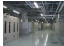
写真4 地下4階機械室
