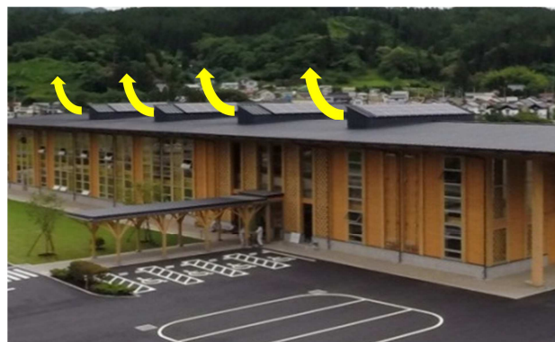
写真 4-1 トップライト自然換気口
