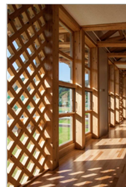
写真 4-2 採光用耐力壁
