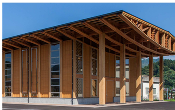
写真 4-3 日射を遮蔽する深い庇
