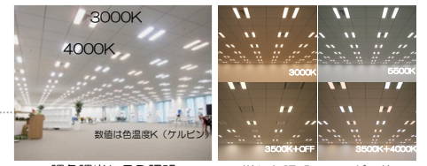
調色調光LED照明 様々な照明シーンが可能
