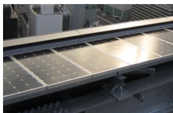
屋上外周面に設置された太陽光パネル
