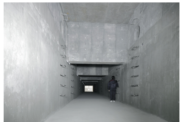
クールヒートトレンチ内部。
