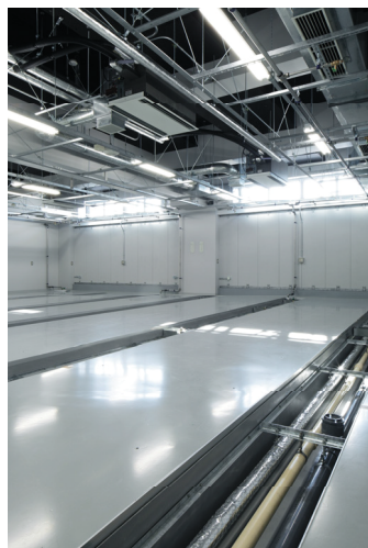
標準実験室。床に「ユーティリティピット」を配置（蓋開放時）
