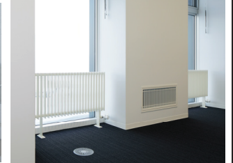
パネルヒーター・床吸込口・壁面吸込口。
