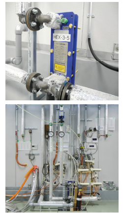
実験排熱回収システム。
