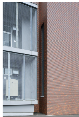
貯雪塔脇に設けた外気取入
