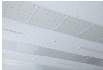
天井輻射パネル。
