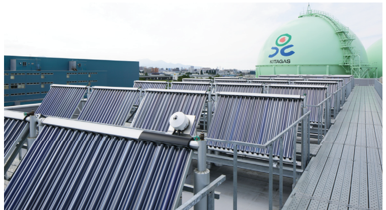
屋上に設置されたソーラー集熱パネル。
