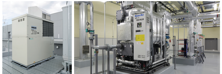
天然ガスを熱源とするソーラー吸収式冷水発生機・コージェネレーション装置。
