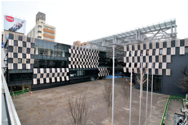
施設入口外観
