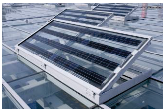
太陽光パネル
