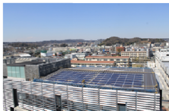
写真5 屋上に設置された太陽光発電パネル
