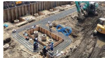
写真3 地中熱交換配管敷設状況
