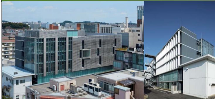
写真2 低環境負荷ファサード (左：南西より 右：北西より)
