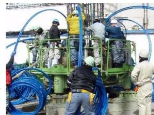
図11 地中熱交換杭施工写真
