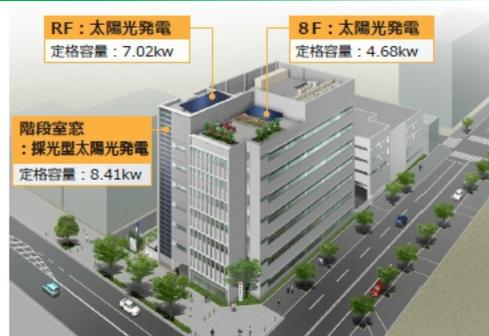
図-15 太陽光発電設備定格容量
