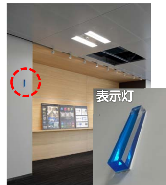
■ 自然換気有効表示灯
