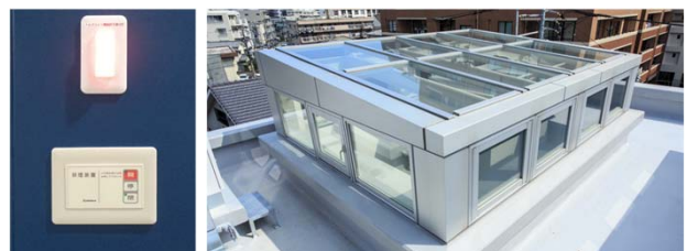
窓開放許可表示灯と換気窓操作部 階段室上部に設置された換気窓
