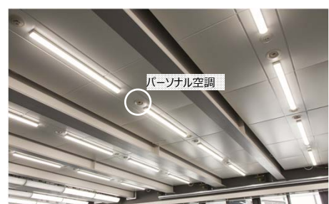
天井放射パネルとパーソナル空調、照明設備を一体化
