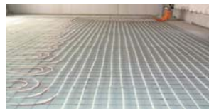
躯体埋設配管敷設状況
