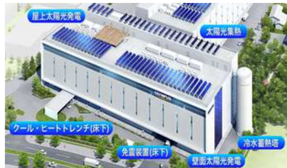
省エネルギー対策・再生エネルギー利用設備等の配置
