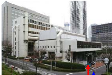
千里エネルギーセンター
