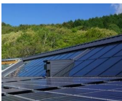
太陽熱集熱パネル
