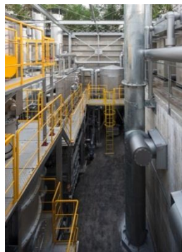
バイオマスガス化コジェネレーション
