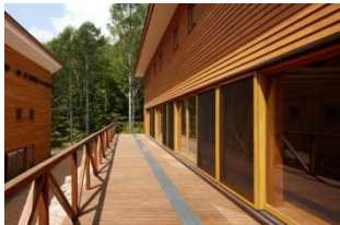
執務室前のウッドデッキ
