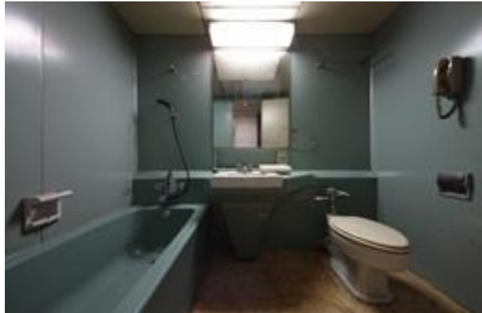
初代ユニットバスルーム（解体前）
