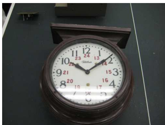
電気時計設備の子機(天井付)
