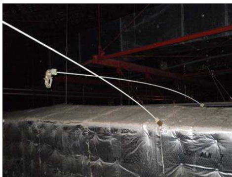
写真 15.1 ダクトの吊り元が破断した例*
