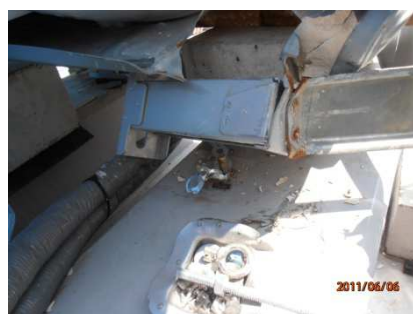
写真 1.2 同左 崩れた脚部* (基礎から落下した機器を基礎上に仮置きして使用)
