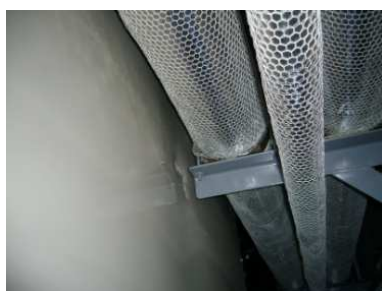
写真 3.2 ダクト横振れによる壁の損傷*
