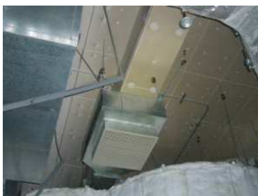
写真 3.4 横振れで吊りボルトを变形させた横引きダクト末
