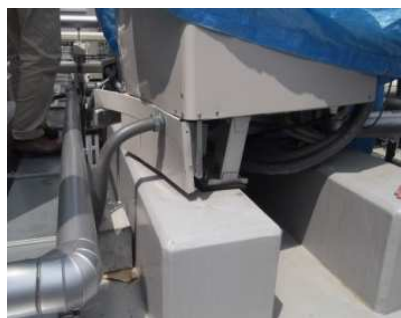
写真 1.1 脚部が損傷した例*
