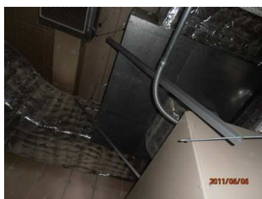
写真 3.1 傾いた給気チャンバー*
