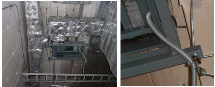
写真 2.2 吊りボルトが変形した送風機*
