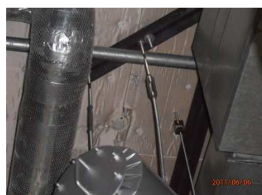
写真 3.5 煙道の横振れによる吊りボルトの变形*
