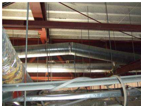
写真 15.2 ダクト継手部の折損*
