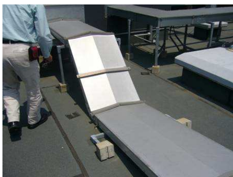
写真 14.1 置き基礎が転倒した例*
