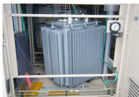
写真 E-3 : 変圧器の移動事例
