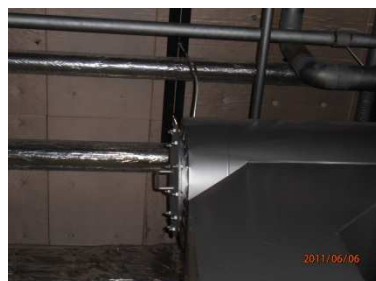
写真 3.5 煙道の横振れによる吊りボルトの变形*
