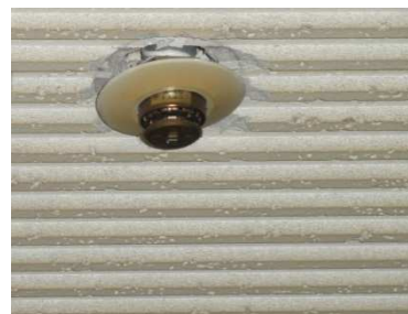
写真 9.2 同左(2)* (一部から散水した)
