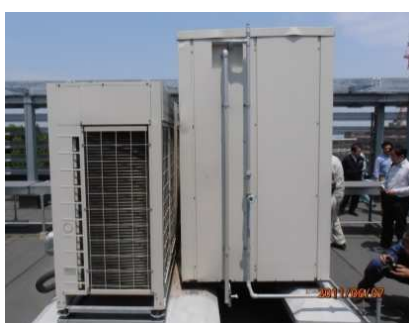
写真 1.3 脚部が損傷した例*
