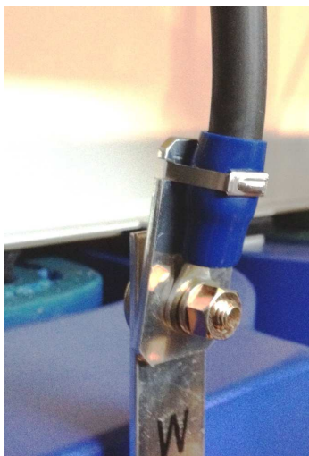
写真E-4②：端子破断防止用添板の例
