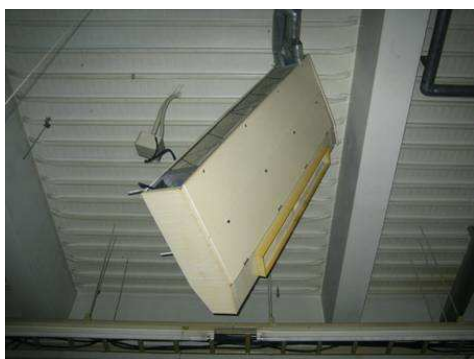
写真 11.1 FCU の吊り元が破断した例
