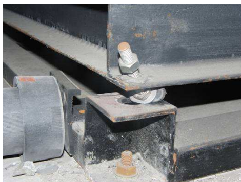
写真 12.1 空調機耐震ストッパーの破断
