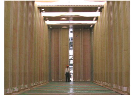
⑩底板・側板組立完了
