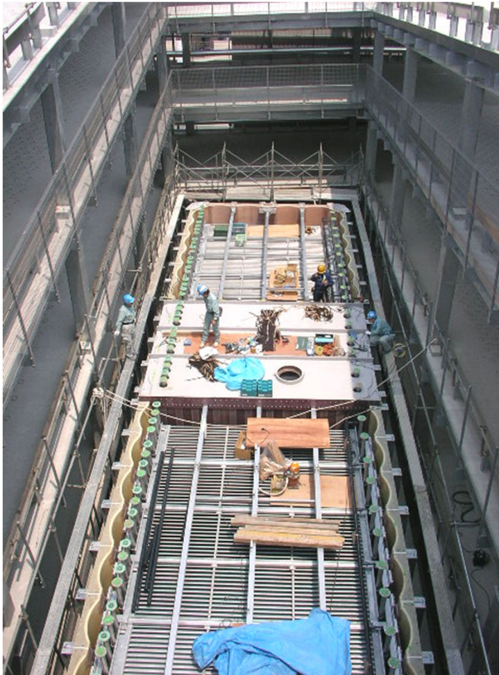
[4] コイル押さえ鋼材・天板取付
