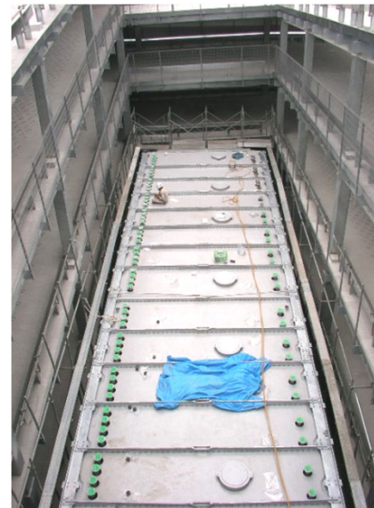
・水槽組立完了
