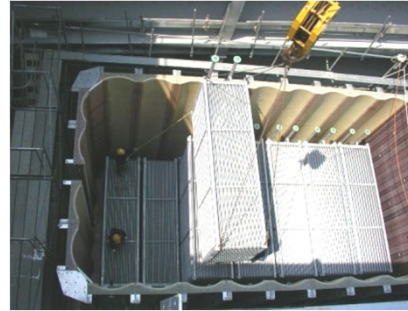
⑱コイル押さえ鋼材取付
