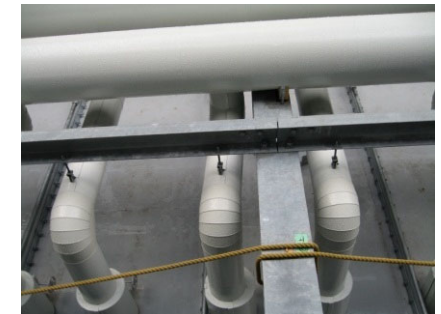
・ブライン配管施工完了
