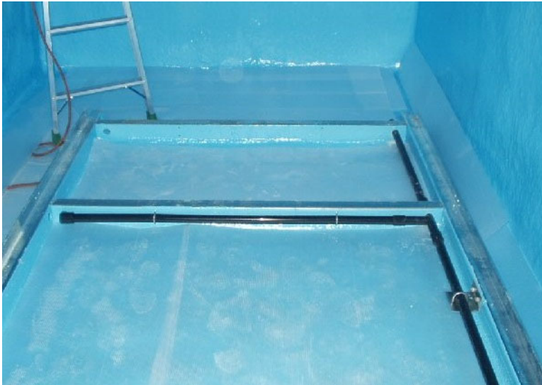
コイル組立て(エア配管)
