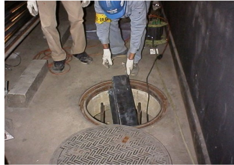
マンホールから部材搬入
