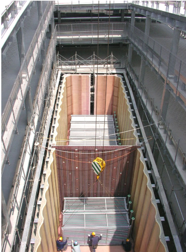
[3] 蓄熱コイル設置
