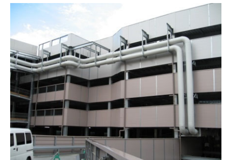
・ブライン配管施工完了
