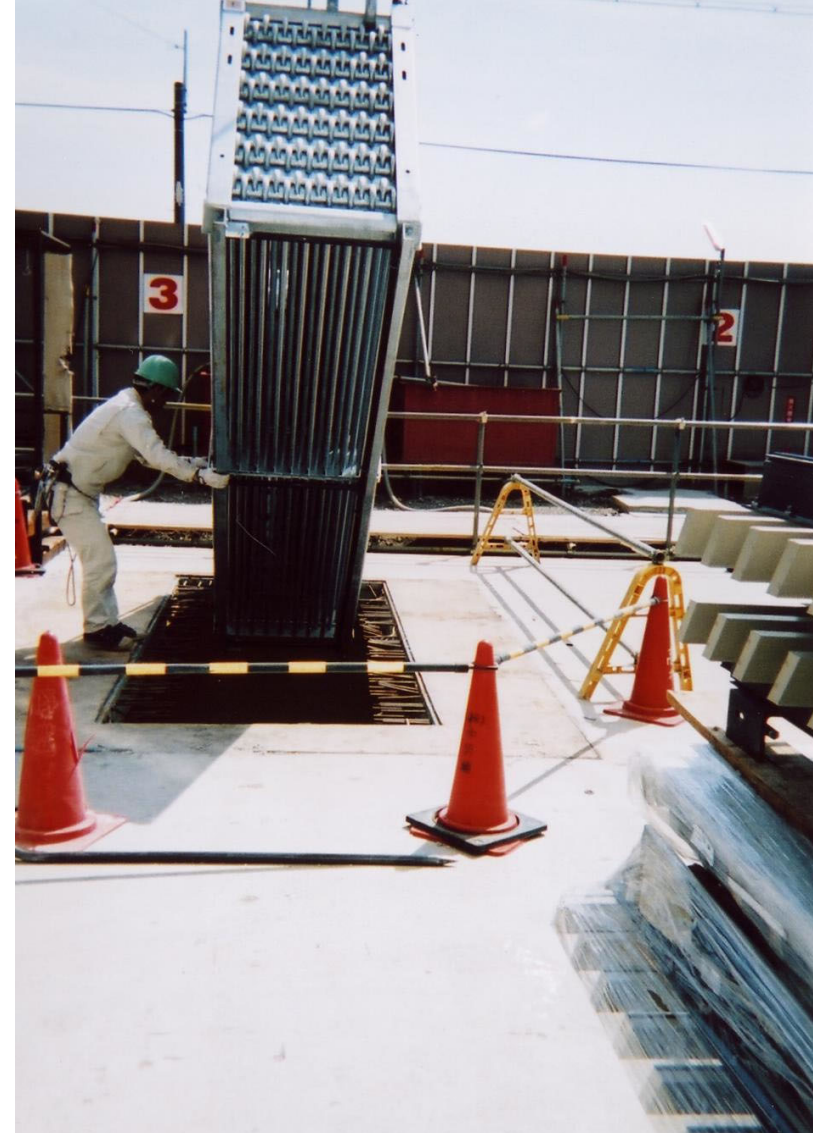
搬入開口よりピット内にコイル搬入①
