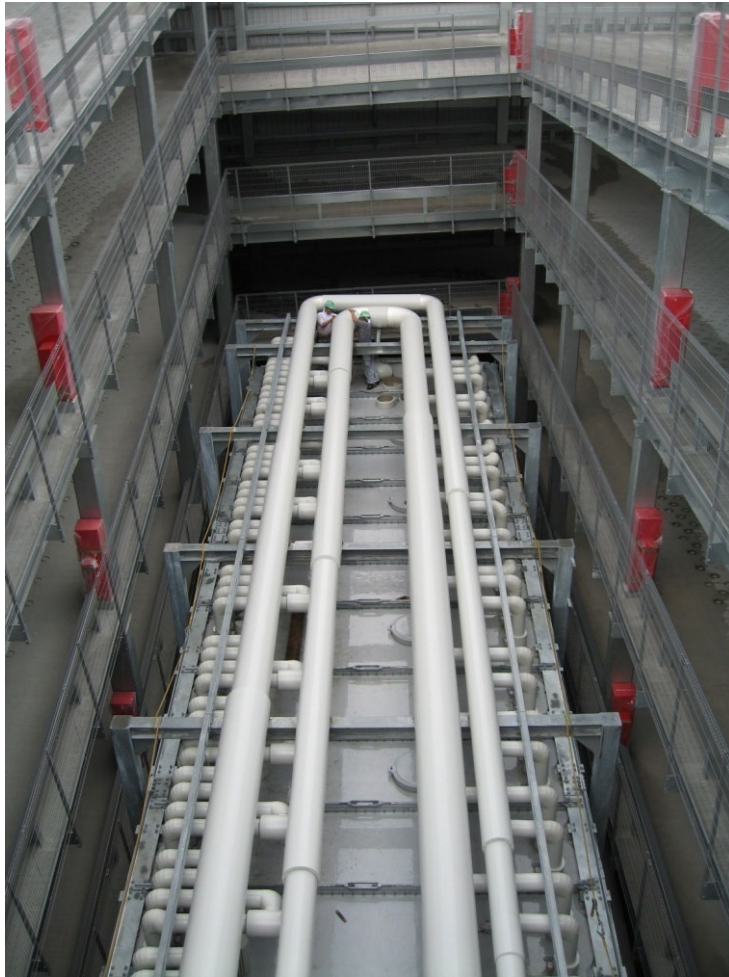
[6] 配管施工完了
