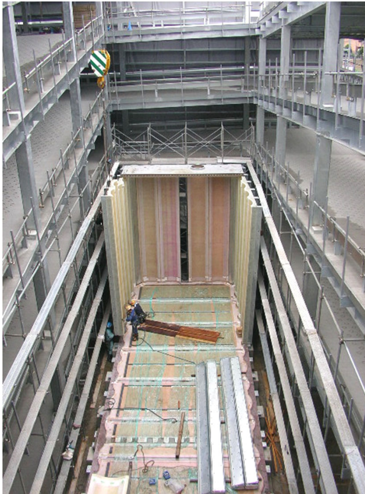
[2] 底板・側板組立
