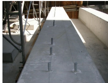
②アンカーボルト打設
