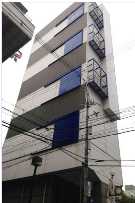
クーリングタワー棟 吸込側外観
