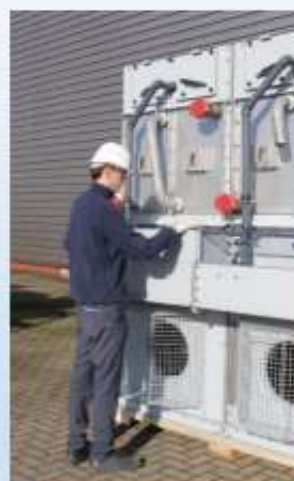
カバー付き散水槽 運転中でも槽内検査ができます
