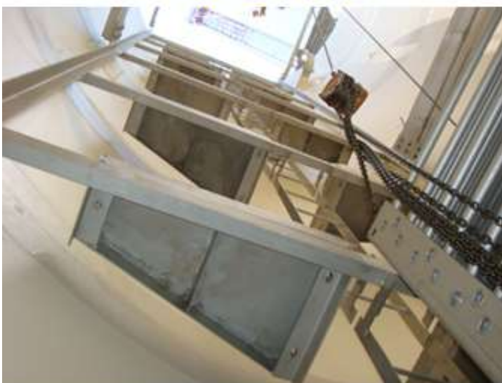
氷蓄熱コイル水槽内取込
