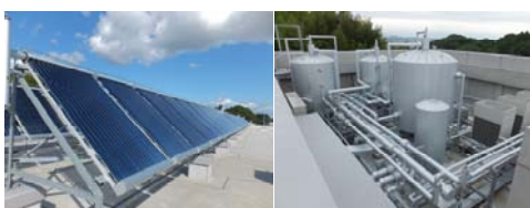
写真-6. ハイブリッド給湯設備
