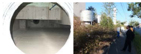
写真-3. クール・ヒートトレンチ及び給気口
