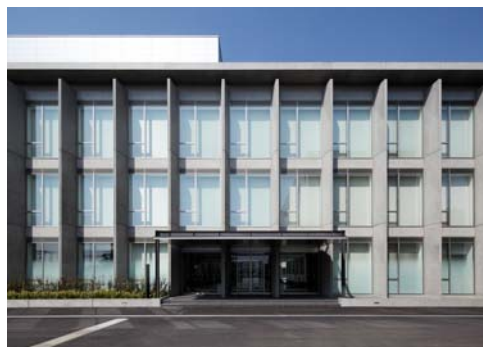
写真-4. 東側立面写真(縦庇)
