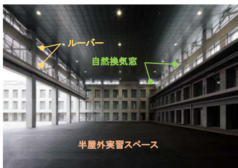
写真-5. 半屋外実習スペース
