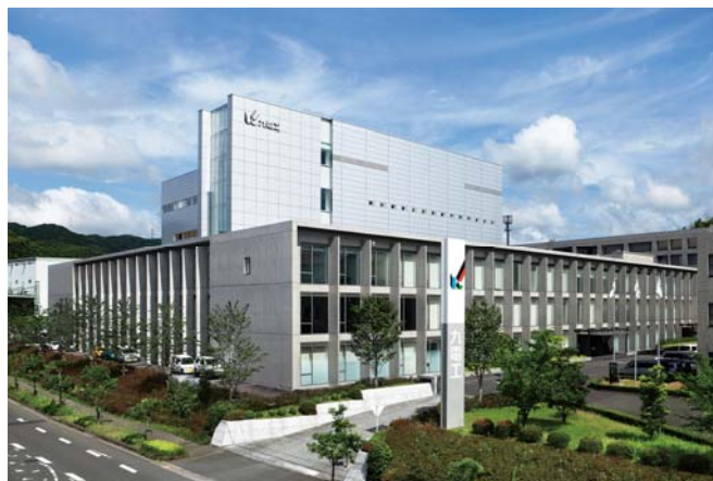
写真-1. 施設前景（南東面ファサード）
