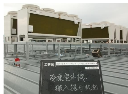
図7. 高効率冷凍・冷蔵設備(設置後)
