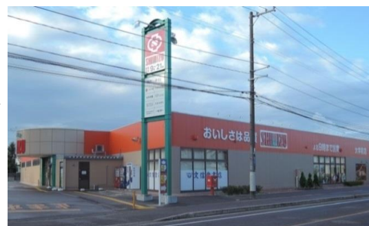
図3. 施設外観写真(改修後)
