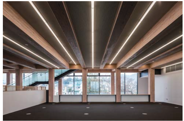
1階執務室 LED照明
