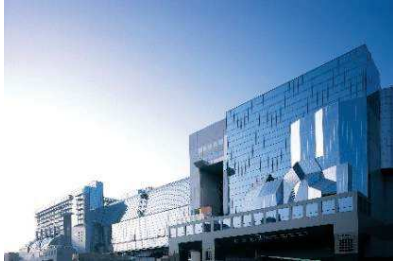
写真1 建物外観（北面）
