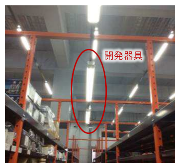
写真-3 開発器具設置状況
