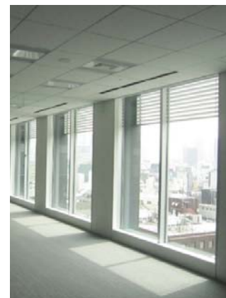
写真4 室内採光状況
