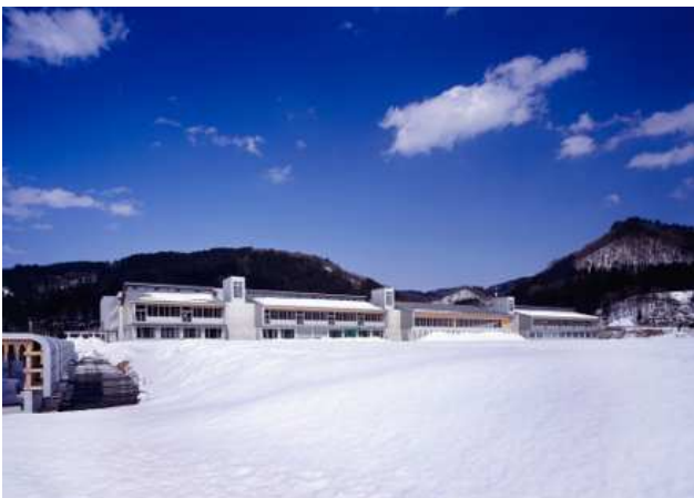
冬の南棟 換気塔のあるコアを挟み、木造校舎を連続させた
