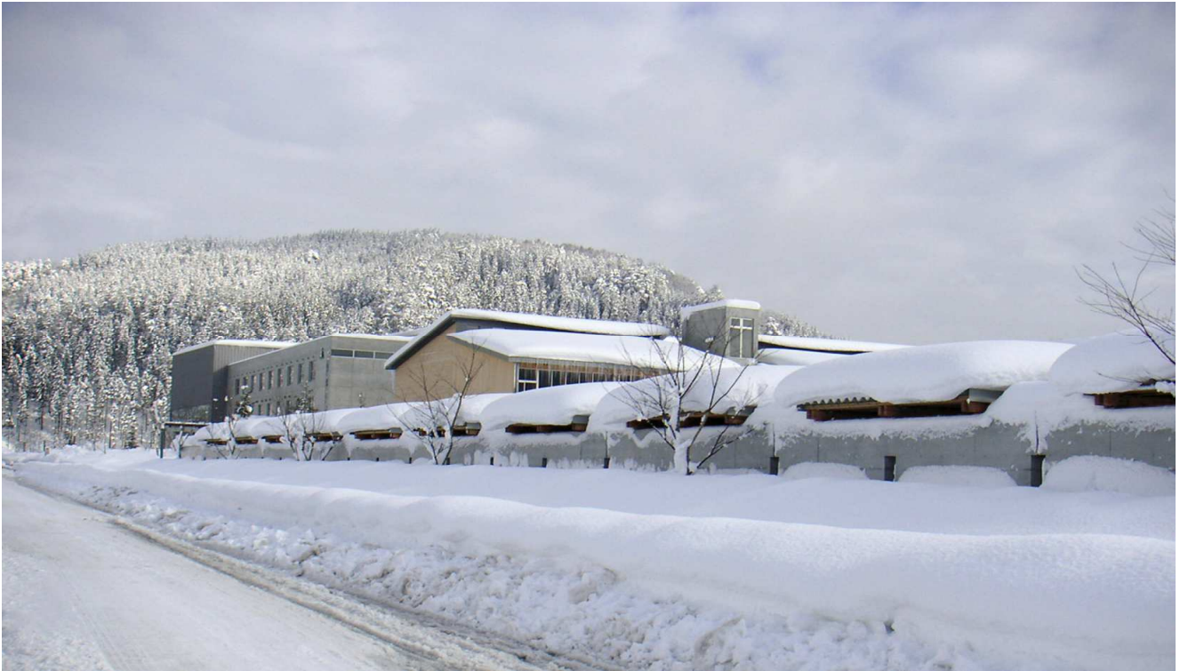
冬の南西側外観 市道に沿った駐輪場が防雪壁を兼ねる
