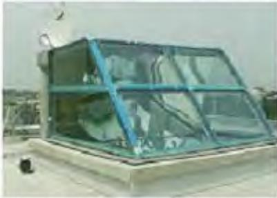
屋上に設置された採光部は、南向に置して大きな開口を持ち、固定の反射ミラーによって、自然光を下方(ダクト内)へ採り入れます。
