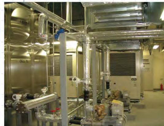
衛生機械室内に設置されたHP給湯機
