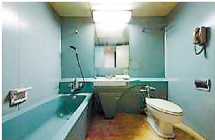
TOTOの初代ユニットバスルーム (解体前)
