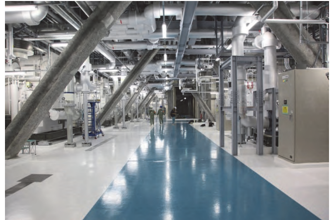
事業者：大阪エネルギーサービス他 建物名：大阪エネルギーサービス第2プラント 設計：三菱地所設計 高田 修、大林組 島 潔 施工：大林組、高砂熱学工業 解説：「美しい熱源機械室を作る」という決意のもと、 配列や色使いにこだわり仕上げられた機械室 投稿者：大林組 島 潔
