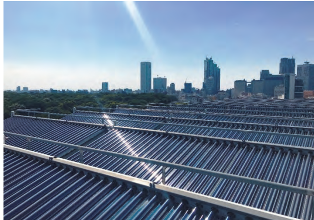
建物名：コープ共済プラザ 設計者：村松宏 (日建設計) 施工者：木下博史 (前川製作所)、萩原正人 (フジタ)、 柚木光吉 (きんでん) 解説：熱、光、緑、超高層のコラボレーション 投稿者：村松宏 (日建設計)
