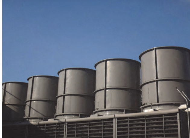
建物名：ヤンマー本社ビル “YANMAR FLYING-Y BUILDING” 設計者：日建設計 (水出喜太郎・杉原浩二) 施工者：竹中工務店 解説：紺碧の空にそびえる冷却塔のスタックダクト 投稿者：野部達夫 (工学院大学)
