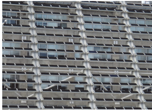
建物名：糸満市庁舎 設計者：棚木学 (日本設計) 解説：RCルーバーとPVパネルが建物を印象的に包み込む。 投稿者：野部達夫 (工学院大学)
