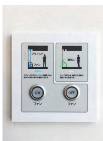
建物名：藤久ビル東5号館 設計者：村松 宏 (日建設計)、小澤 諭 (日建設計)、 千葉美幸 (日建設計) 解説：エアフローファンの発停と自然換気を促す 「環境調整スイッチ」 投稿者：村松 宏 (日建設計)
