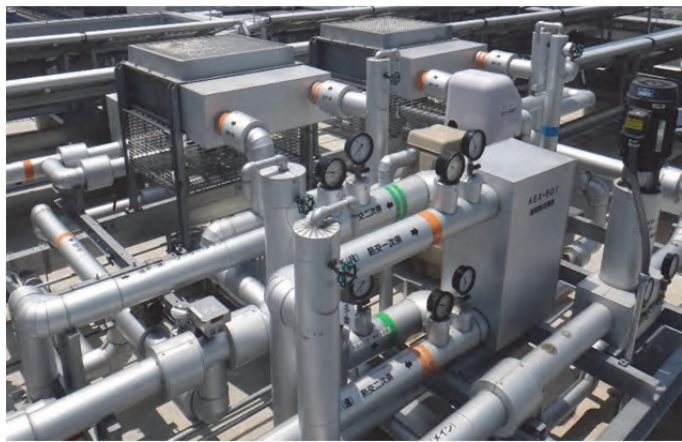
建物名：東京ガス平沼ビル 設計者：丸山純、塩出和人 (松田平田設計) 施工者：杉山聡 (大林組) 日比岡一 (新菱冷熱工業) 解説：エッシャーの無限階段を想起させる配管群 投稿者：野部達夫 (工学院大学)
