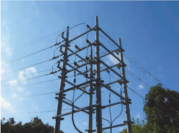
事業者：嘉麻太陽光発電(株) 施設名：嘉麻第一太陽光発電所 (福岡県) 設計：高司 健二 (関電工) 施工：関電工 解説：青空に浮かび上がる 22kV コンクリート柱装柱 投稿者：中川 徳仁 (関電工)
