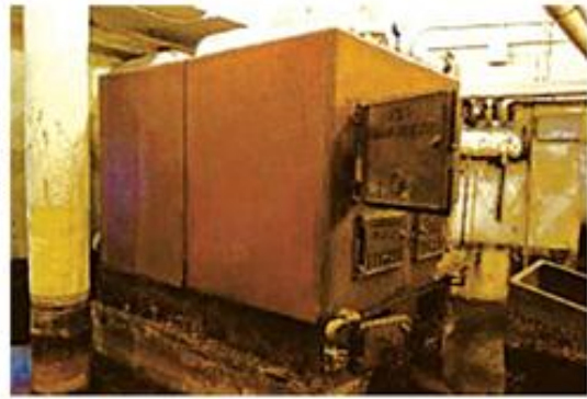
鑄鉄製ボイラー
