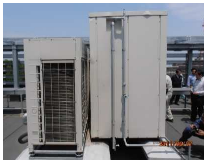
写真 1.3 脚部が損傷した例*
