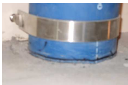
写真 10.2 給水管移動の実験例 (b) (立管 100A、分岐管 50A。層間変位 1/67 時)
