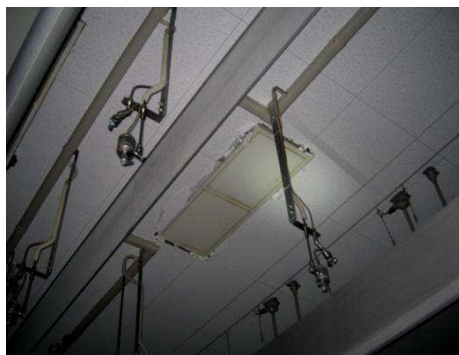
写真 18.1 排煙口周囲の天井の損傷*
