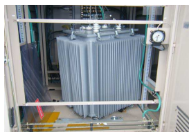
写真 E-3 : 変圧器の移動事例
