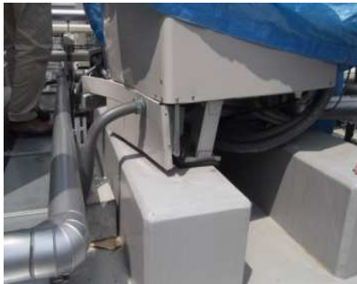
写真 1.1 脚部が損傷した例*
