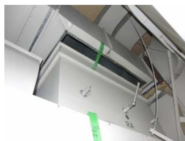
写真 3.3 ダクト変位によるフランジの損傷*
