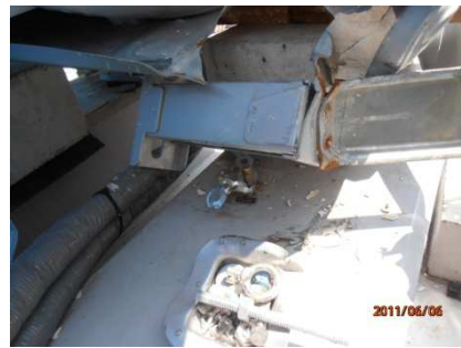
写真 1.2 同左 崩れた脚部* (基礎から落下した機器を基礎上に仮置きして使用)
