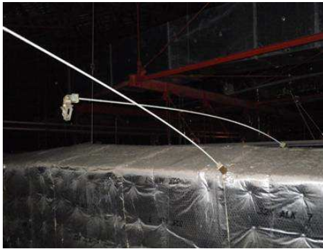
写真 15.1 ダクトの吊り元が破断した例*
