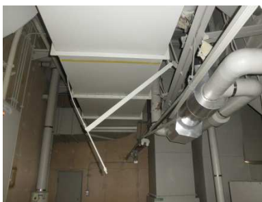
写真 4.1 傾いた共通吊り部材(1)*
