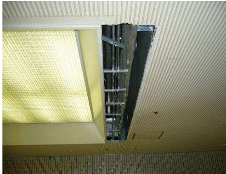
写真 16.1 ライン型吹出口の落下した例*
