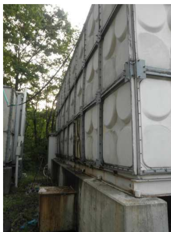
写真 8.1 損傷した水槽* (耐震仕様品でない。フレームが湾曲し漏水している)
