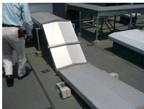
写真 14.1 置き基礎が転倒した例*
