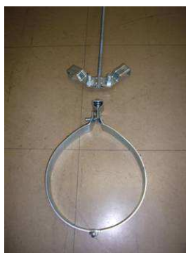
写真 11.2 配管 1 本吊りの破断
