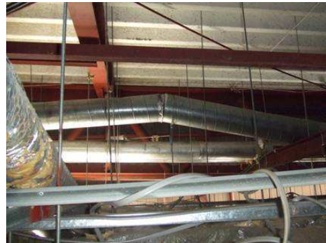
写真 15.2 ダクト継手部の折損*
