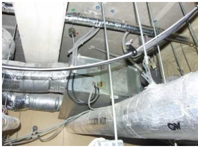
写真 2.1 傾いた空調室内機*
