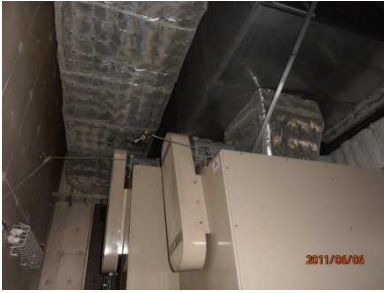
写真 5.1 吊りボルト抜け状態(1)*
