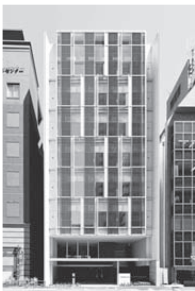
写真-1 建物外観
