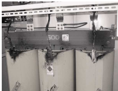
写真E-4① 変圧器一次側端子部損傷例
