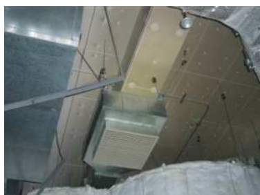
写真 3.4 横振れで吊りボルトを変形させた横引きダクト末端*
