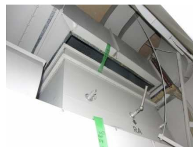
写真 3.3 ダクト変位によるフランジの損傷*
