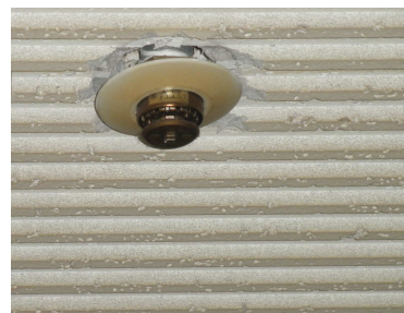
写真 9.2 同左(2)* (一部から散水した)
