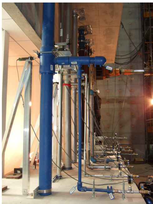
写真 10.1 層間変位 1/67 時の立管の変位状況 (a) (建築研究所の実験例：2009 年)
