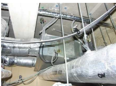
写真 2.1 傾いた空調室内機*
