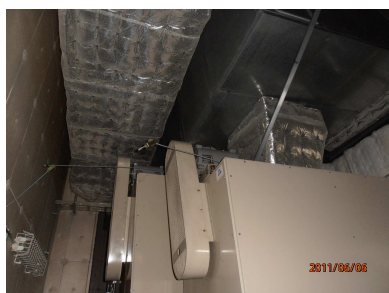
写真 5.1 吊りボルト抜け状態(1)*
