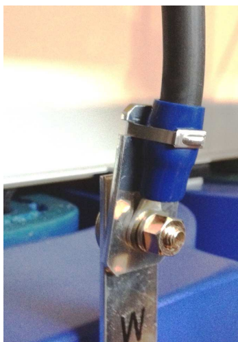
写真E-4② 端子破断防止用添板の例
