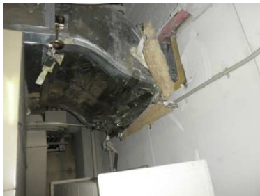
写真 3.8 横振れによりラッキングが損傷した横引き配管*
