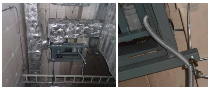
写真 2.2 吊りボルトが変形した送風機*
