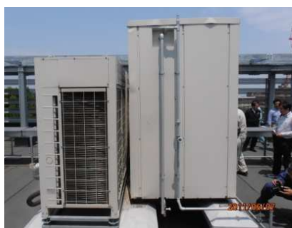
写真 1.3 脚部が損傷した例*
