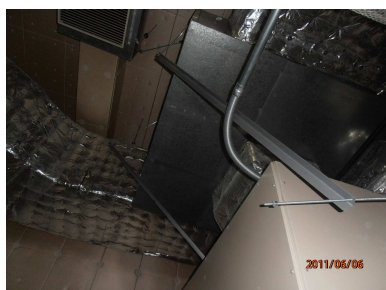
写真 3.1 傾いた給気チャンバー*
