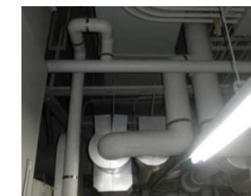
写真 3.6 機械室壁を貫通するダクト変位(1)*
