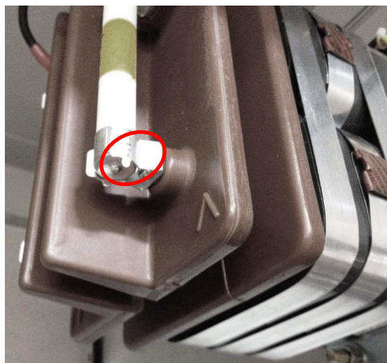
写真E-8② VT用ヒューズの脱落防止例
