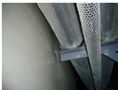
写真 3.2 ダクト横振れによる壁の損傷*
