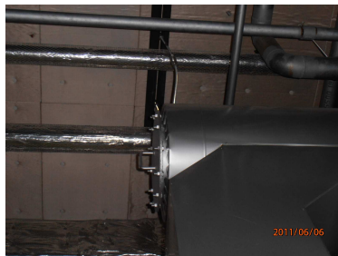
写真 3.5 煙道の横振れによる吊りボルトの変形*
