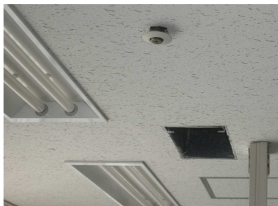
写真 9.1 天井ボードを損傷したスプリンクラーヘッド(1)*
