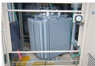
写真E-3 変圧器の移動事例
