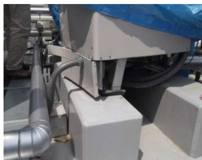
写真 1.1 脚部が損傷した例*
