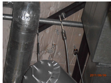
写真 3.5 煙道の横振れによる吊りボルトの変形*
