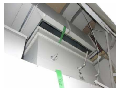
写真 3.3 ダクト変位によるフランジの損傷*
