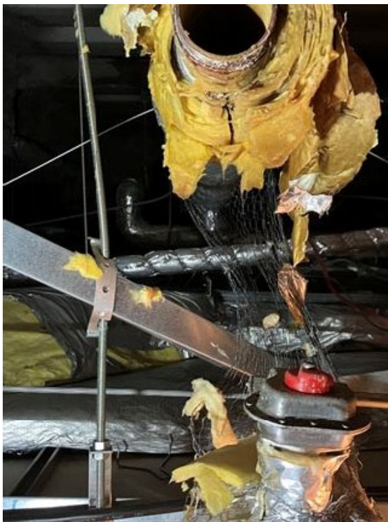
図 4.11.2 配管の破断
