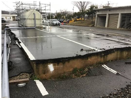
(c) 建築物周囲の地盤沈下，浄化槽
