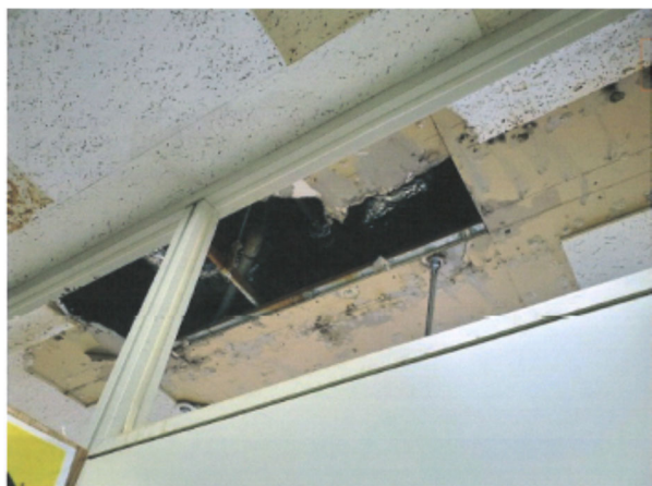
(a) 天井ボードの落下状況（施設管理者より提供）
