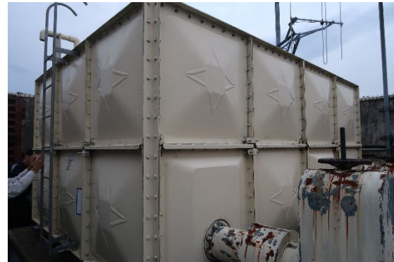
図 4.29.6 高置タンク（繊維強化プラスチック製）
