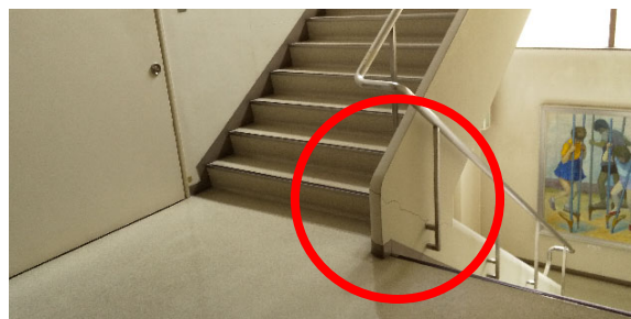
(b) 階段腰壁損傷箇所
