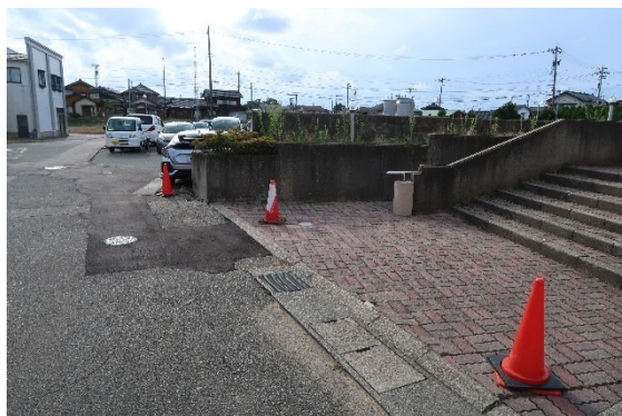
図 4.28.7 建築物 AB 東側の地盤変状
