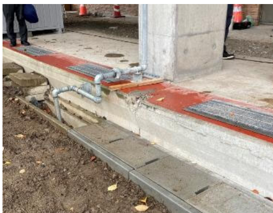
図 4.12.2 地盤沈下で生じた 40 cm の段差
