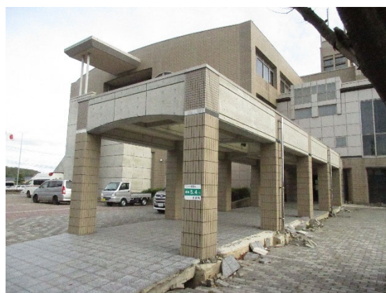
図 4.28.8 建築物 AB 北西側の地盤変状
