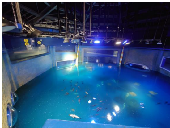
(e) 漏水により水位が低下した水槽
