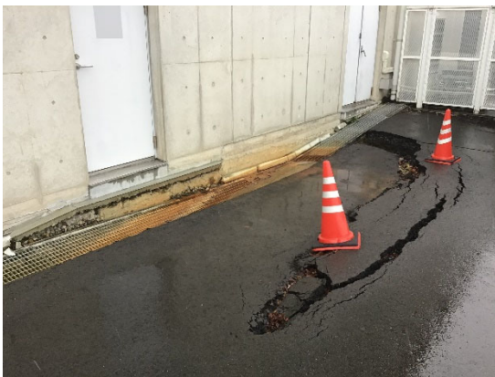
(a) 建築物外周の沈下
