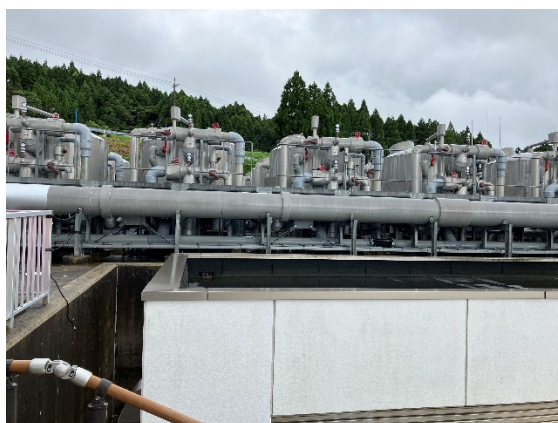
図 4.7.6 ろ過装置（復旧後）
