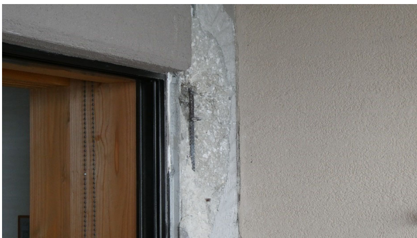
図 4.9.3 鉄筋の露出（屋外より撮影）
