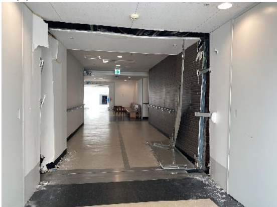
(c) 3号棟5号棟の間のエキスパンションジョイント（内側）（施設管理者より提供）
