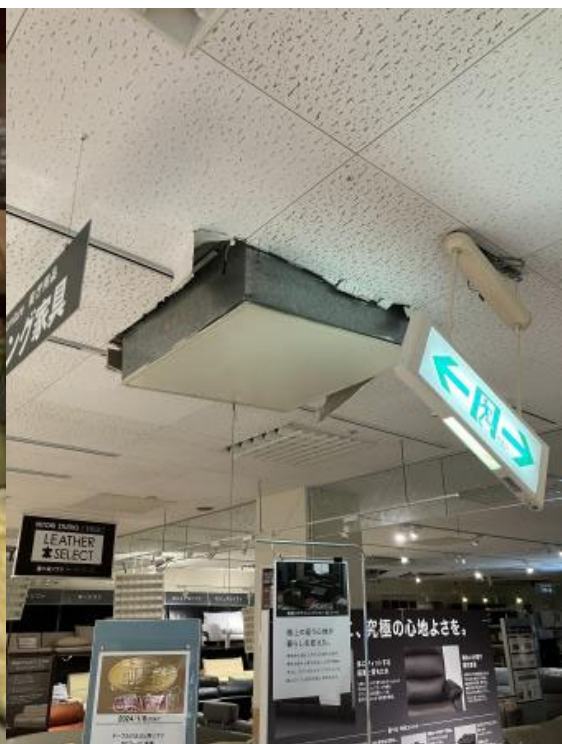
図 4.11.5 排煙口パネルの脱落
