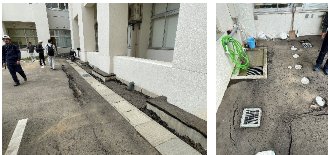
(b) 中庭の地盤沈下の状況
