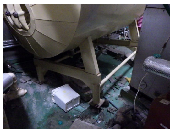
図 4.21.6 3 病棟屋上のストレージタンクの被害状況（施設管理者より提供）
