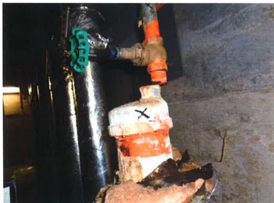
(a) エア抜き配管損傷箇所
