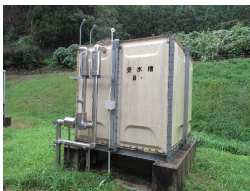
図 4.4.5 屋外受水タンク（建築物 D）
