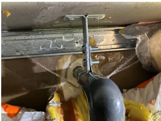
(a) 純水配管の破損
