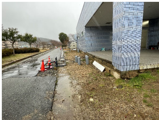
(a) 建築物周囲の地盤沈下，排水樹
