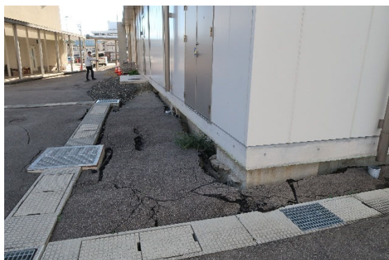
図 4.31.5 外構部の地盤変状
