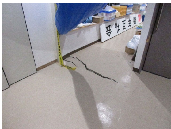
図 4.32.5 3 階床の損傷
