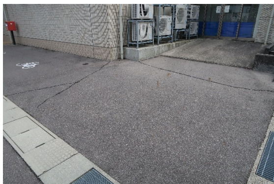
図 4.33.18 建築物 AG-4 周辺の地盤変状
