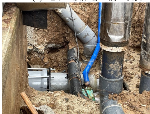
(f) 地中埋設管破断・漏水箇所
