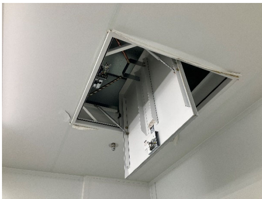
(a) 地震により開放した排煙口
