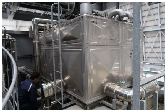
図 4.27.7 高置タンク（ステンレス製）
