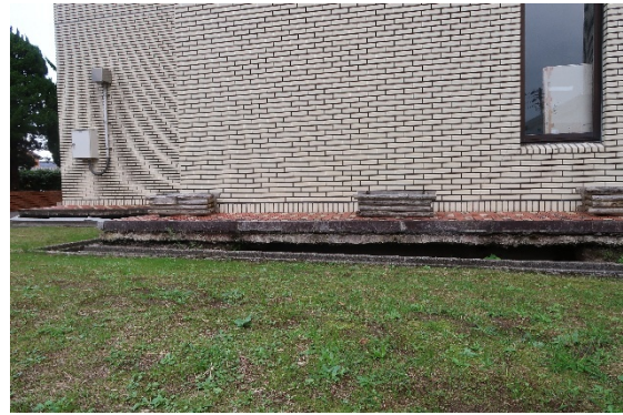
図 4.29.8 建築物 AC 北側の地盤変状
