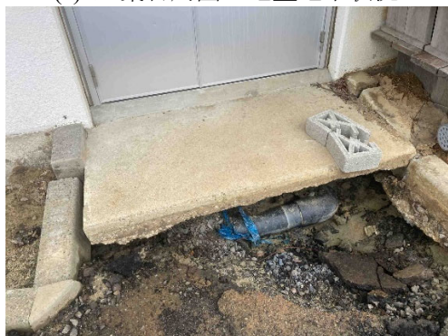
(c) 地中埋設配管の破断・漏水箇所
