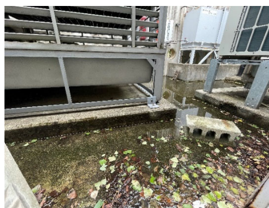
図 4.1.6 冷却塔置場の浸水（建築物 A）
