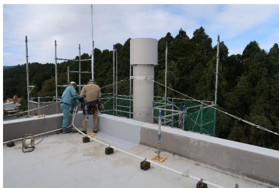
図 4.30.12 煙突の新設（建築物 AD-1）
