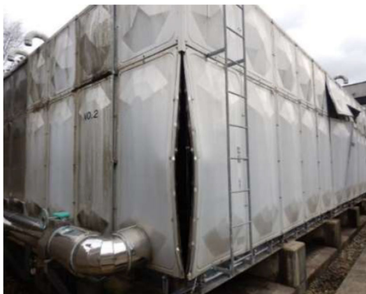
(b) 受水タンク破損状況
