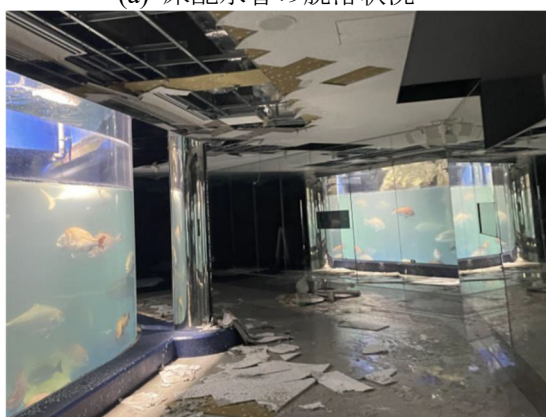
(c) 床配水管の漏水による天井落下状況
