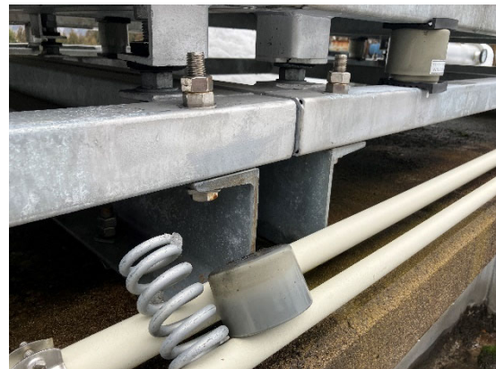
図 4.26.9 防振スプリング脱落
