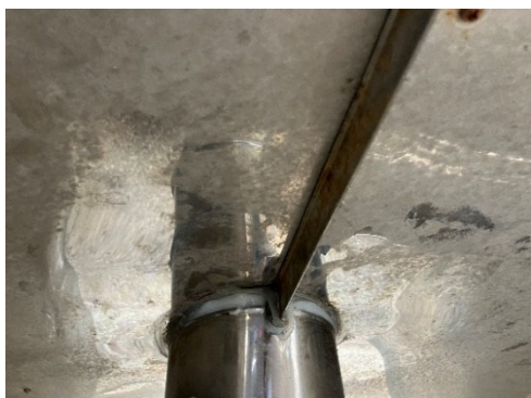
図 4.2.5 ボイラ用補給水タンクの修繕箇所
