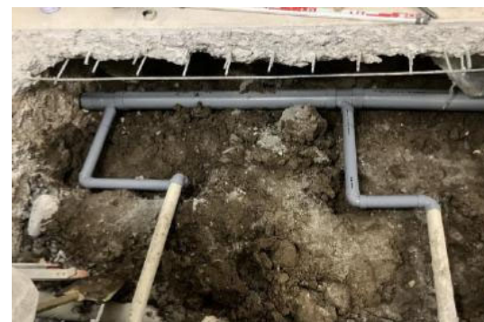
図 4.12.6 土間配管の破損状況（左）と復旧工事の状況（右）
