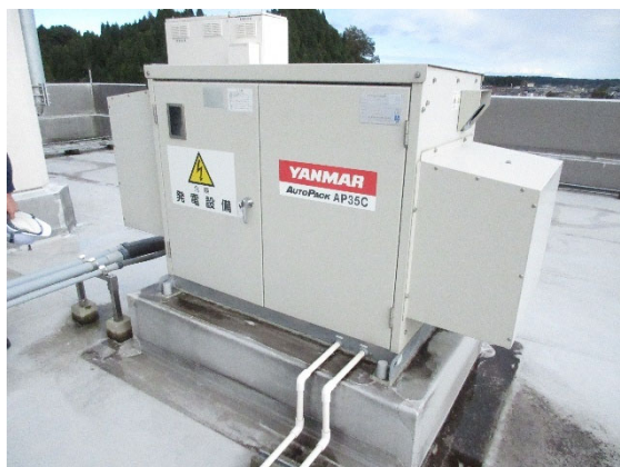
図 4.30.5 自家発電設備（建築物 AD-1）
