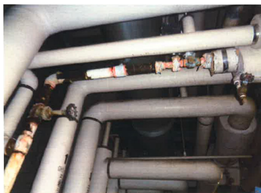
(a) 冷温水配管漏水箇所
