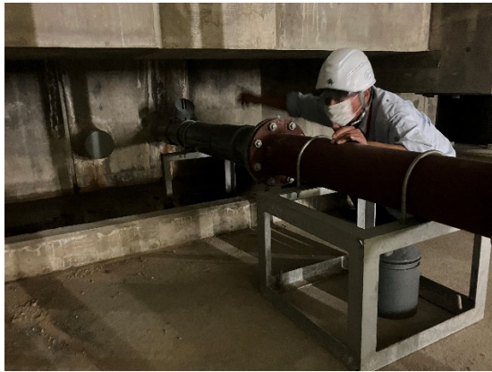
(a) 本館地下の免震層内の配管
