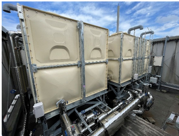
図 4.21.9 地震後に更新したタンク
