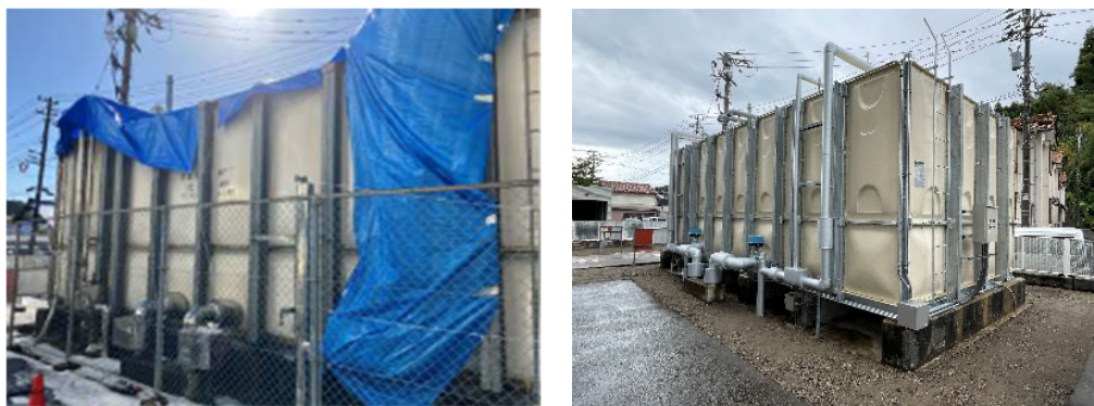
図 4.17.2 破損した受水タンク（左：施設管理者より提供）と更新後（右）
