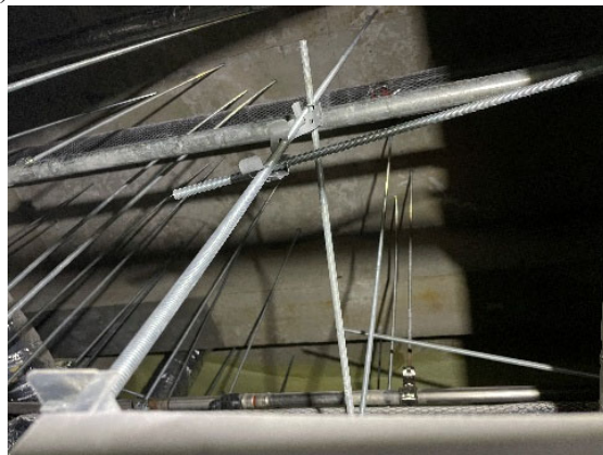
(d) ファンコイルユニットの吊り支持状況
