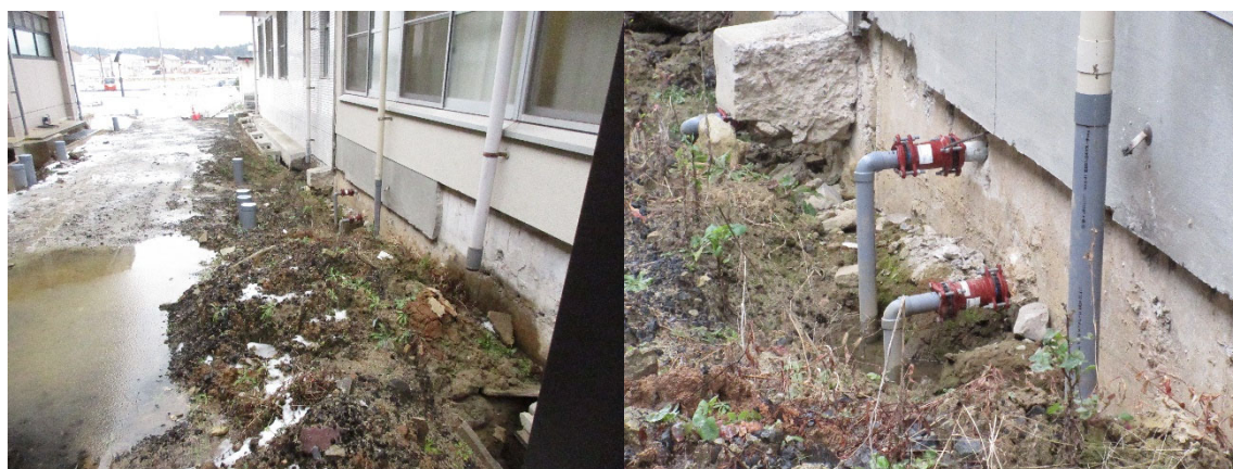
(c) 建築物周辺地盤の沈下
