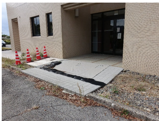
図 4.33.15 外構部の地盤変状
