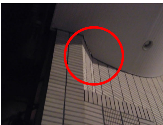
(a) ホール天井損傷箇所
