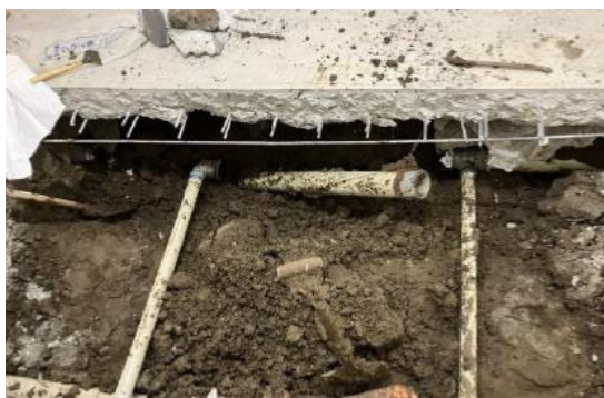
図 4.12.6 土間配管の破損状況（左）と復旧工事の状況（右）
