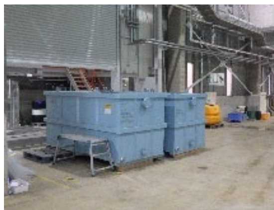
(b) プラント冷却用仮設タンク
