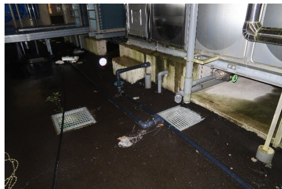
図 4.32.10 受水タンクの仮設配管
