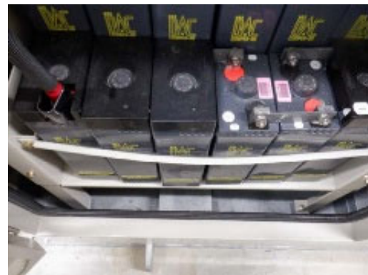
(b) バッテリー損傷
