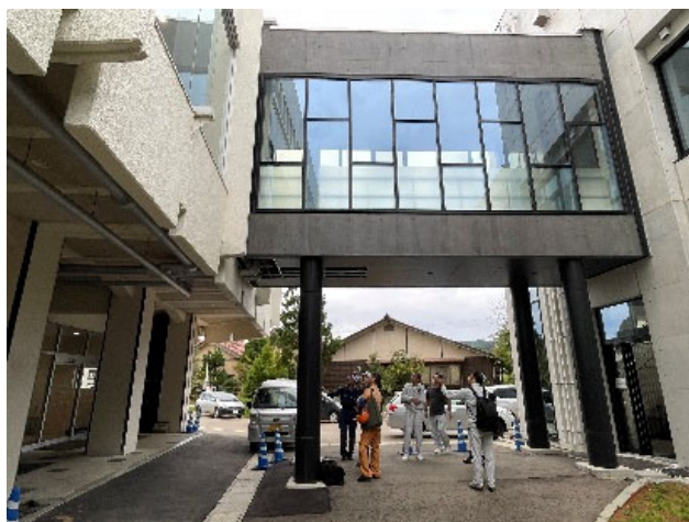
図 4.15.2 消火設備配管が断裂し漏水した渡り廊下
