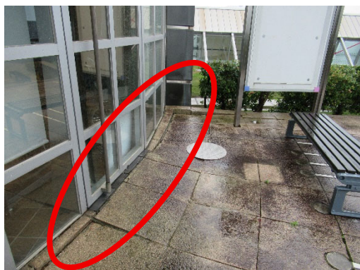
図 4.4.2 入口付近地盤沈下 (建築物 D)
