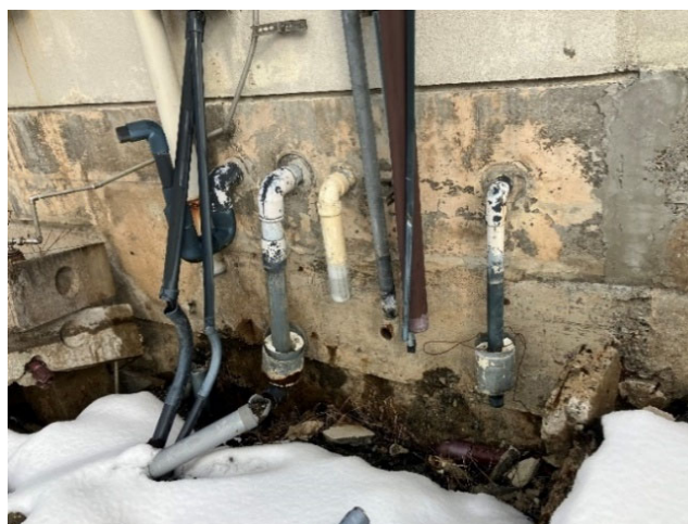
図 4.26.4 地盤沈下と配管の破断（建築物 Z）
