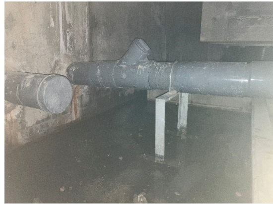
(a) 本館地下の免震層内の配管
