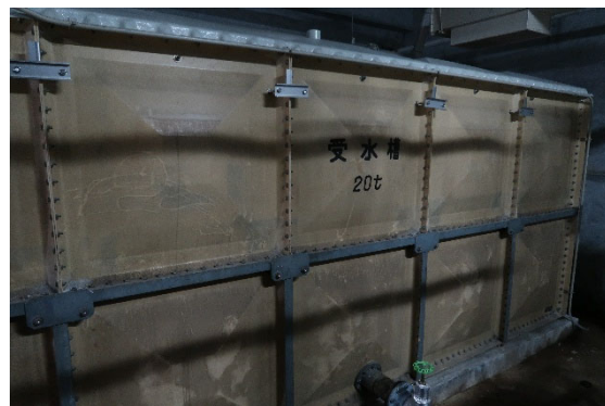
図 4.30.8 受水タンク（建築物 AD-1）
