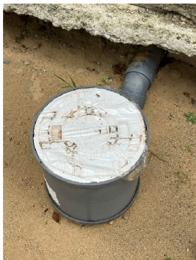
図 4.1.3 仮設マンホール（建築物 A）
