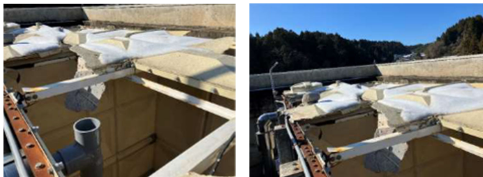
(a) 破損した高置タンク上部（施設管理者より提供）
