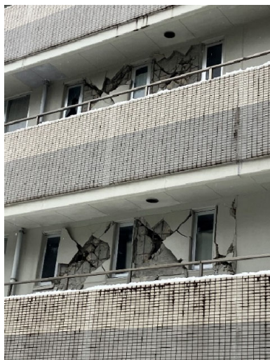
図 4.26.2 方立壁のせん断破壊
