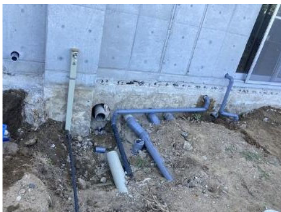
図 4.12.3 排水管の破断・復旧の状況
