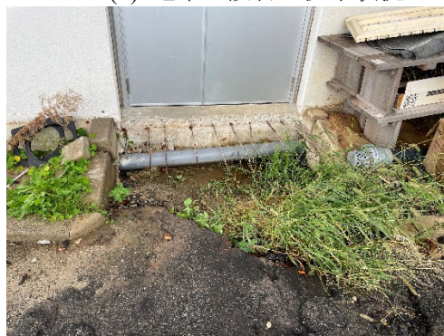
(d) 地中埋設配管の復旧状況
