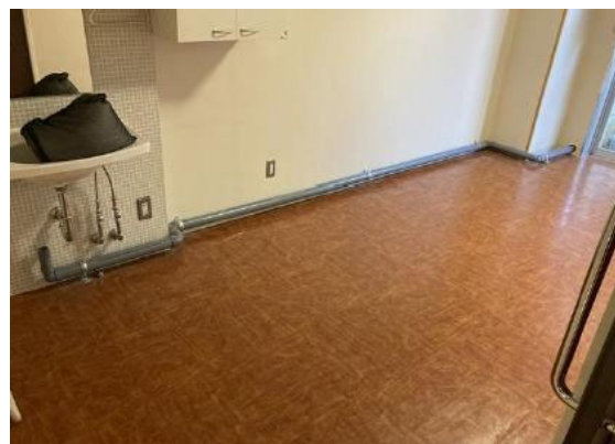
図 4.12.5 露出配管による排水の復旧状況
