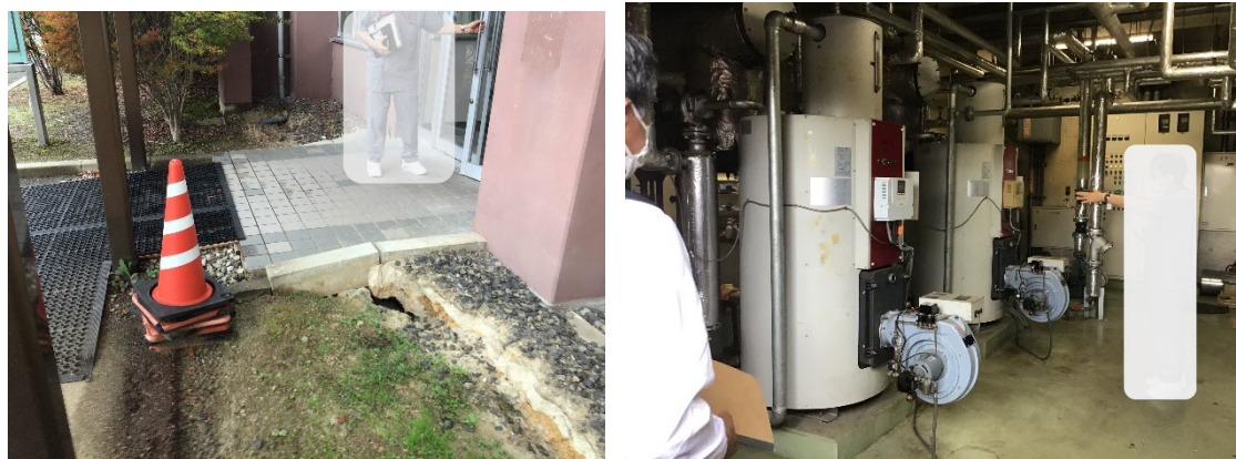
(a) 建築物周囲の地盤沈下状況
