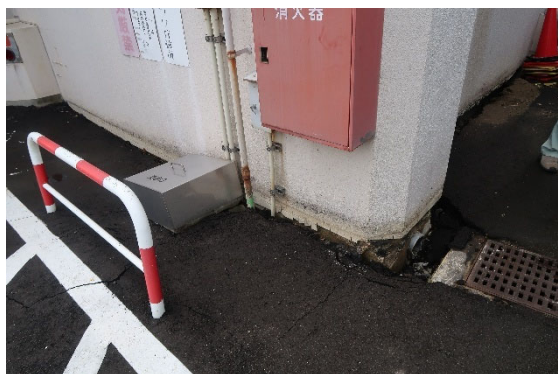
図 4.30.11 外構部の地盤変状
