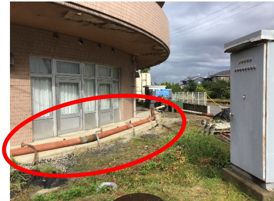
(b) 地下水汲み上げ配管敷設
