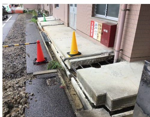
(b) 建築物周辺地盤のずれ
