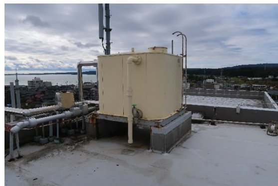
図 4.30.6 高置タンク（建築物 AD-1）
