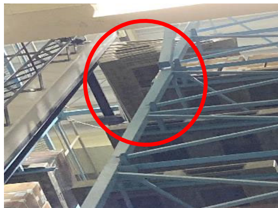
(b) 上部パレットの被害
