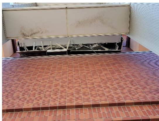
(a) 本館と3号棟の間のエキスパンションジョイント（外側）（右は施設管理者より提供）
