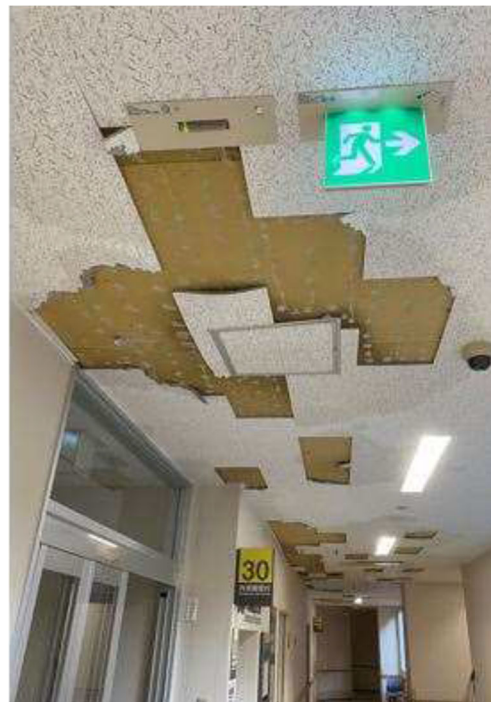
(b) 漏水による天井被害（施設管理者より提供）
