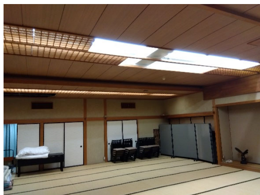
図 4.18.2 大広間の天井材の脱落
