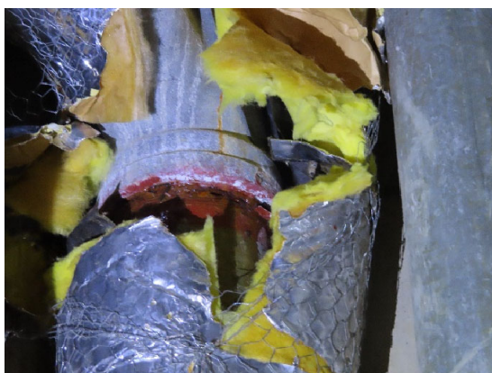
図 4.2.2 雑排水管の補修箇所
