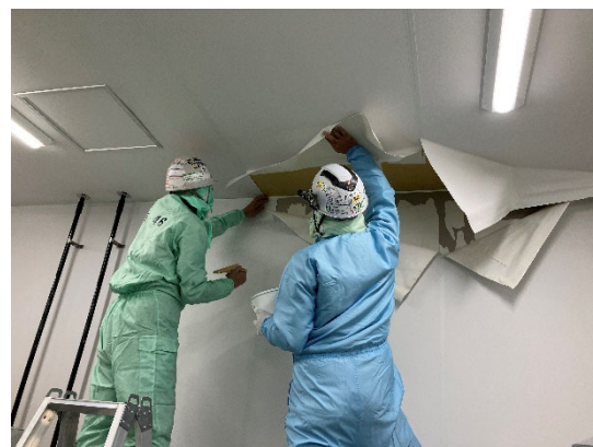
(b) 生産エリア内浸水被害
