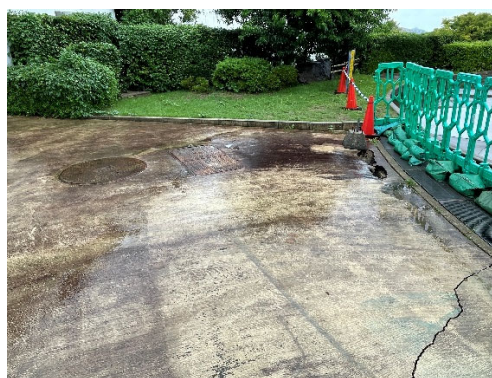
(b) 地中埋設物の沈下状況
