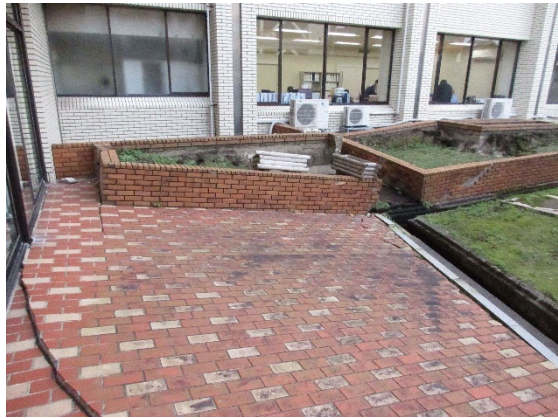
図 4.29.7 建築物 AC 北側の地盤変状
