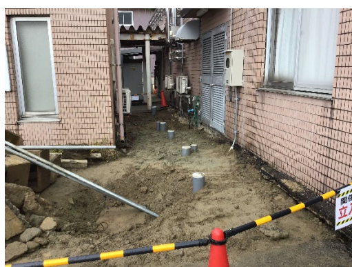
(a) 建築物周囲の排水管復旧状況
