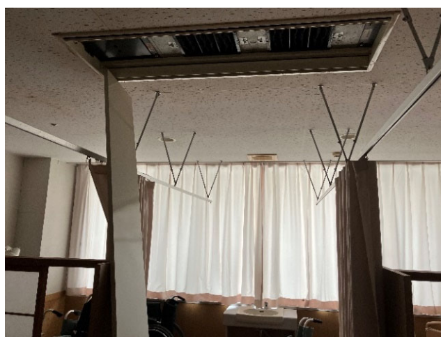
図 4.26.5 ファンコイルユニットカバーの落下（建築物 Z）
