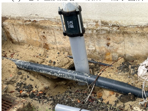
(e) 地中埋設配管の復旧工事中の状況
