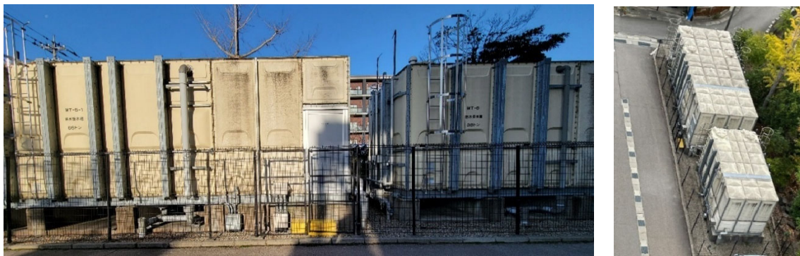
図 4.21.2 地震直後の本館・3 病棟用の受水タンク（施設管理者より提供）
