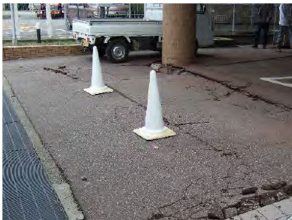
図 4.8.2 建築物周囲の地盤沈下の状況
