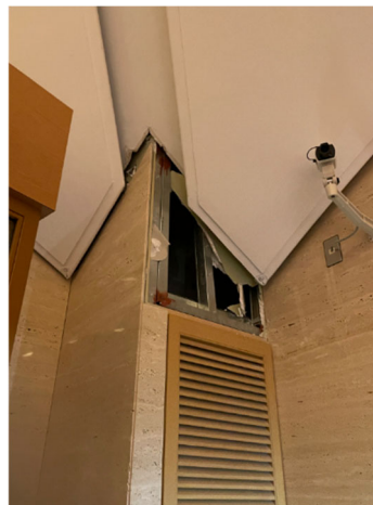
(b) 壁取合い部の損傷
