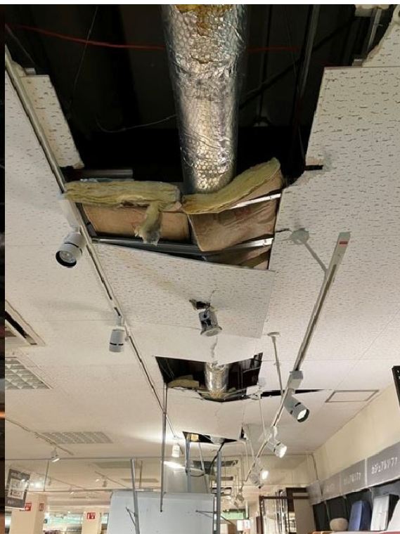
図 4.11.3 配管の脱落
