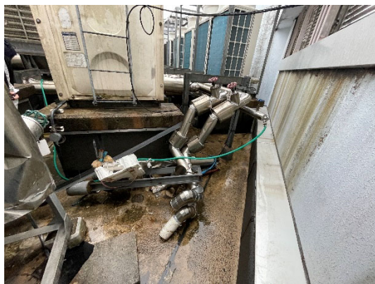
(a) 屋上にて破損した配管
