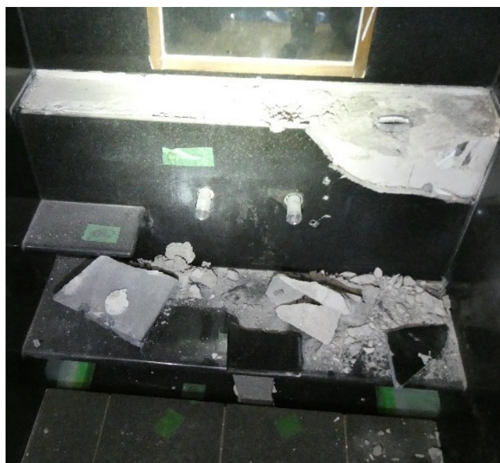
図 4.9.6 洗い場の埋設配管（給水・給湯）
