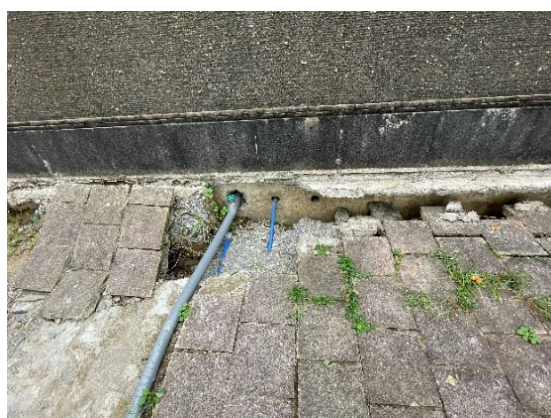
図 4.1.5 給水のバイパス（建築物 A）
