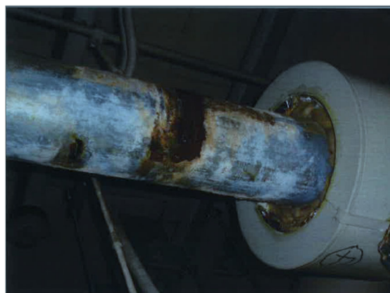
(b) 冷却水配管損傷箇所
