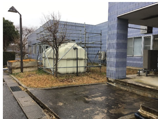
(d) 仮設の浄化槽
