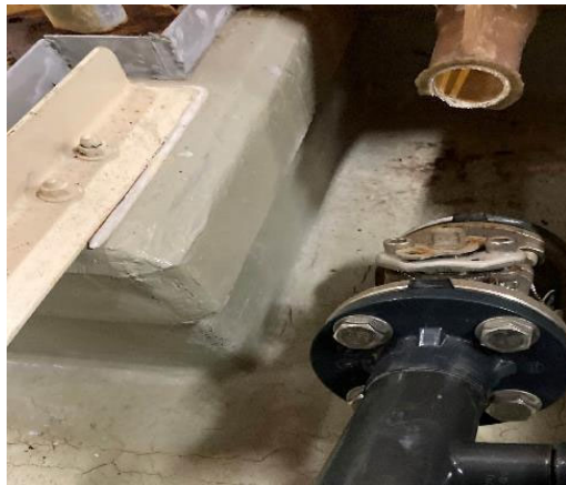
(a) 生産用水タンクの配管の破断
