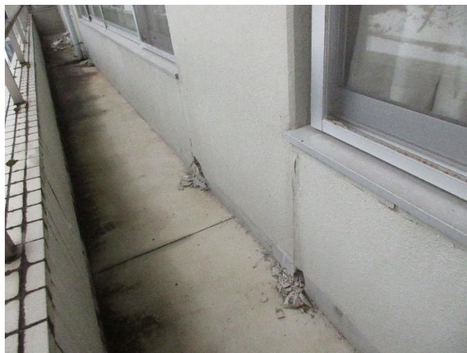
図 4.26.3 2階柱脚の圧壊（建築物 Z）
