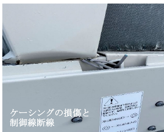
図 4.8.5 屋上空冷ヒートポンプチラーの損傷
