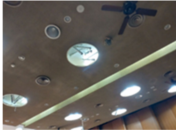
(b) 破損した照明器具
