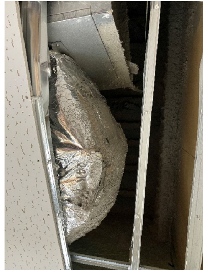
図 4.26.7 外調機の落下（建築物 Z）
