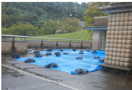
(a) 防水損傷対策
