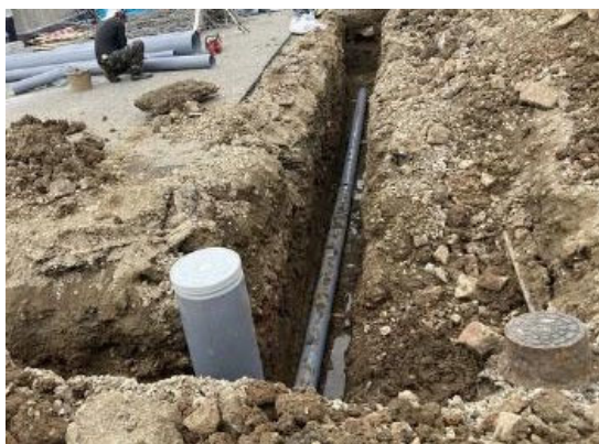
図 4.12.4 メイン排水管の復旧工事の状況
