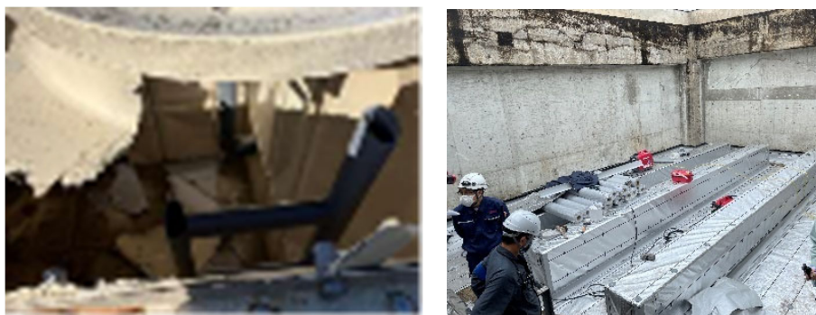
(b) 破損した高置タンクのマンホール（施設管理者より提供）と撤去後の状況（右）
