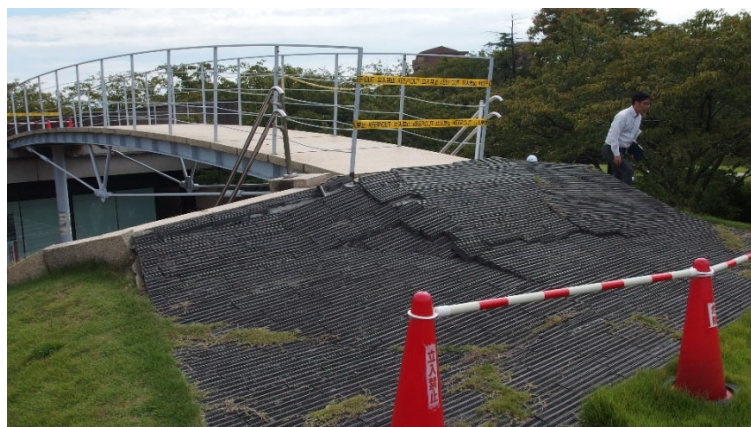
図 4.1.2 2 階出入口導線の被害（建築物 A）
