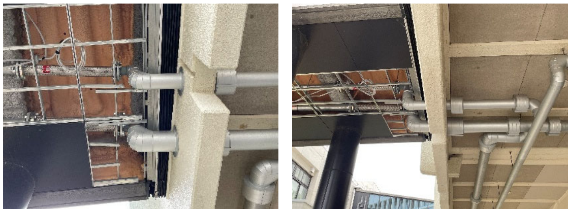
図 4.15.4 渡り廊下エキスパンションジョイント部の消火設備配管復旧状況
