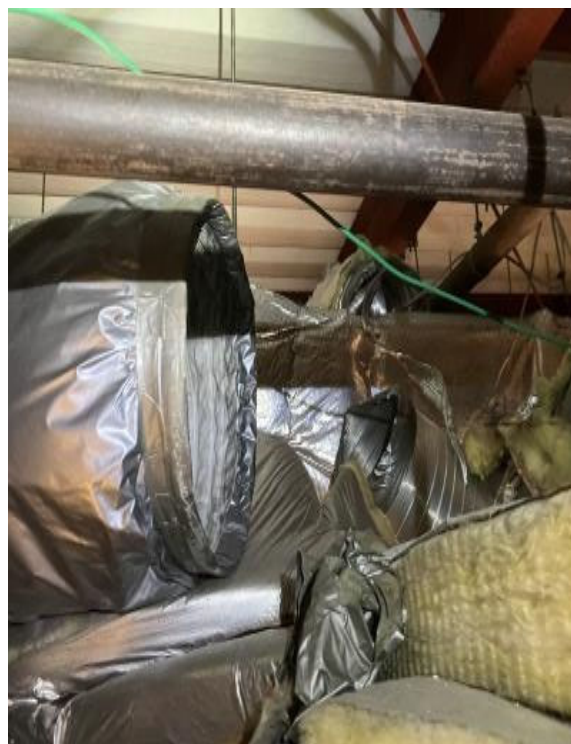
図 4.11.4 ダクトの破断
