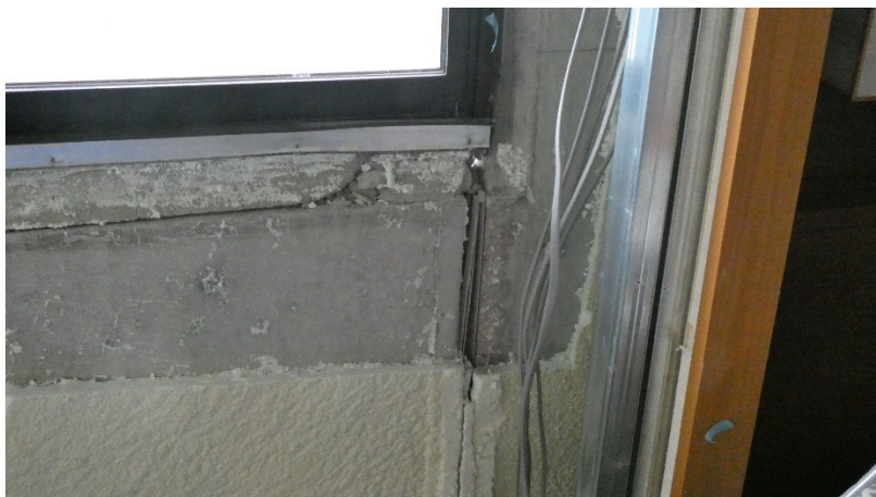
図 4.9.2 外壁のひび割れ（建築物内より撮影）
