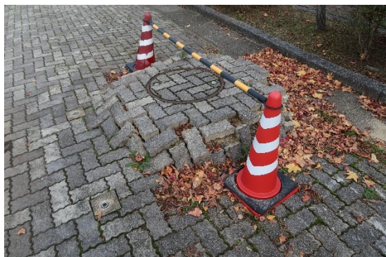
図 4.28.9 建築物 B 西側の地盤変状
