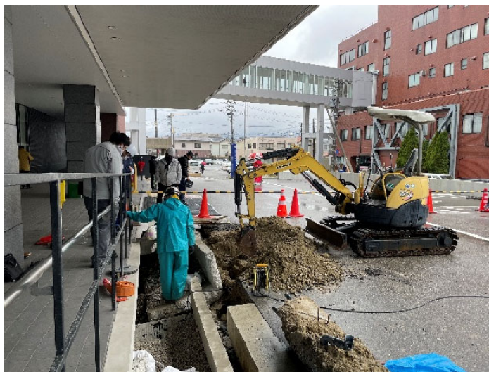
(b) 本館玄関前での埋設排水管の復旧工事状況（施設管理者より提供）
