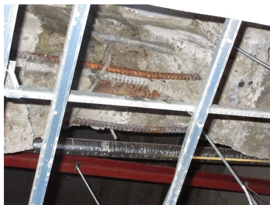
図 4.32.6 屋上階梁の損傷
