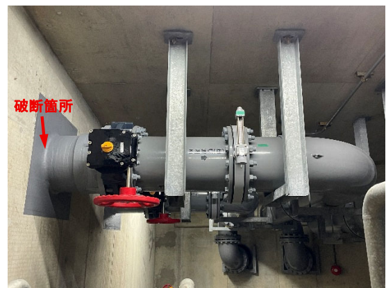
(d) 修復・補強後の循環ろ過配管
