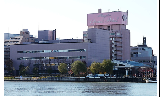
図2.施設外観写真
