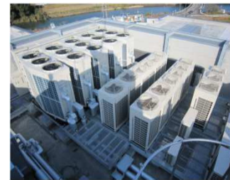
図7.空冷HPモジュールチラー
