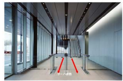
ピット内予熱(エントランス)
