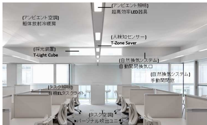
執務室内観と設備機器
