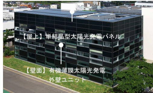
建物全体を利用した創エネシステム
