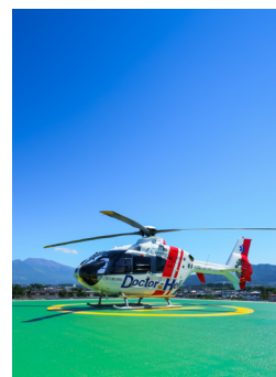
屋上ヘリポート
