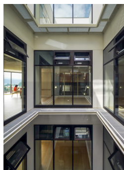
病棟 自然換気窓 （自然換気用エコシャフト）
