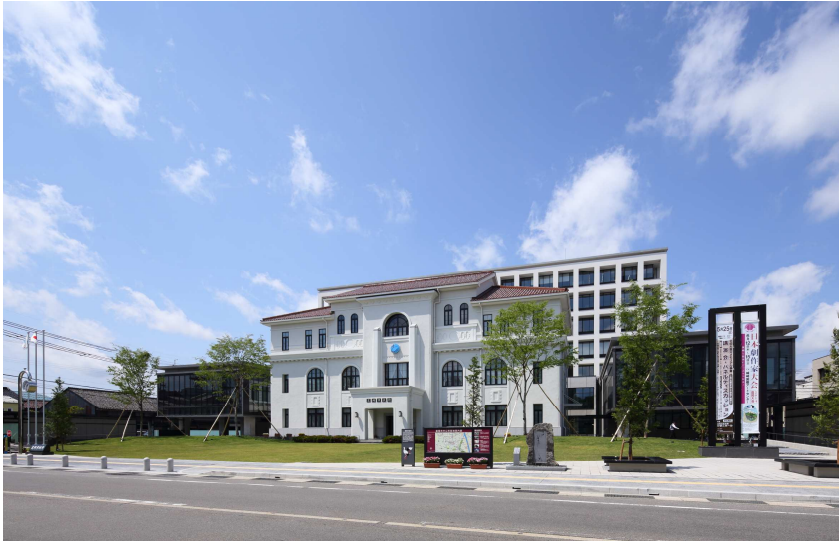
南側外観（手前：旧庁舎再生、奥：新庁舎）
