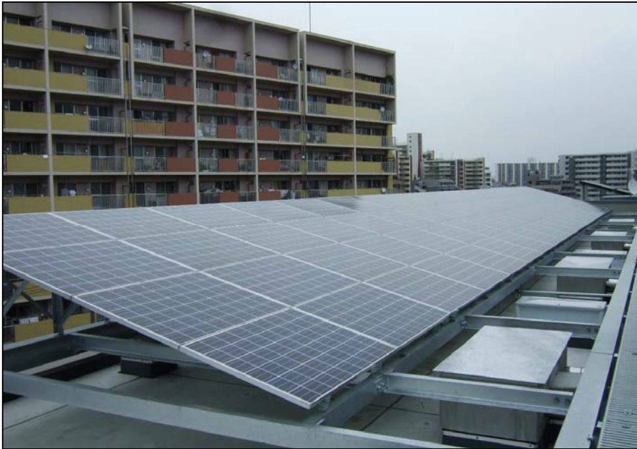
図-8 屋上太陽光発電設備
