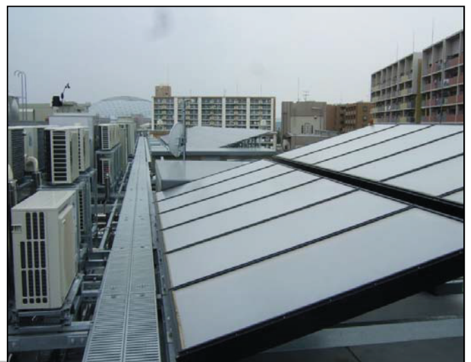
図-10 太陽熱利用設備
