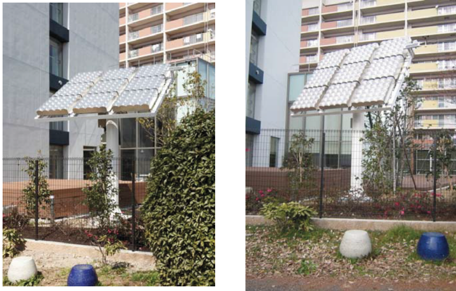
図-12 太陽正対追尾状況 (写真 左より 昼間 夕方 の状態)
