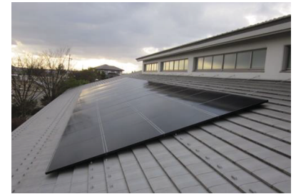
CIS太陽光発電パネルの設置状況
