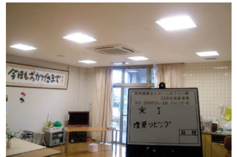
LED照明の設置状況
