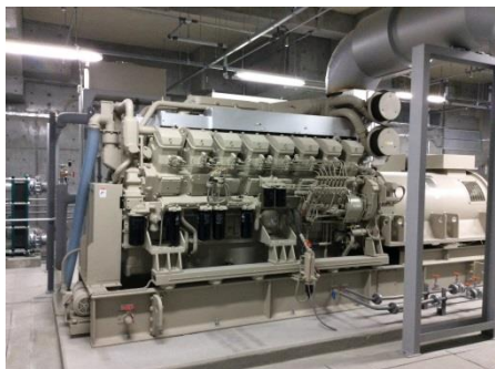
更新後の発電室 1500kVA
