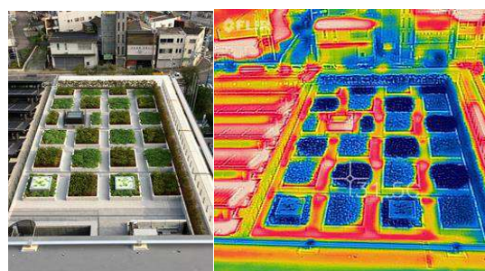
低層階屋上緑化部分のサーモカメラ画像 (2017/7/4 14:00)
