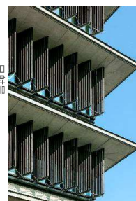
日射遮蔽木製ルーバー写真
