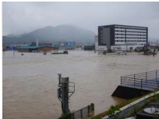
写真-16 C病院建物外観と周辺浸水状況
