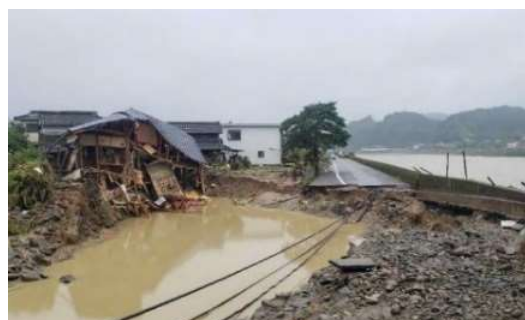
写真-3 球磨川堤防の破損状況（熊本県人吉市）
