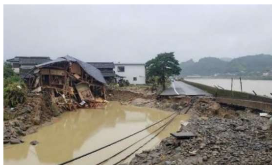
写真-11 球磨川堤防の破損状況
