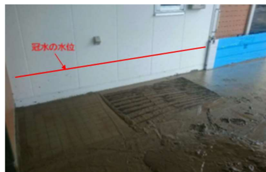
写真-17 C病院 浸水の水位
