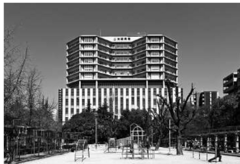
写真-31 I 病院外観
