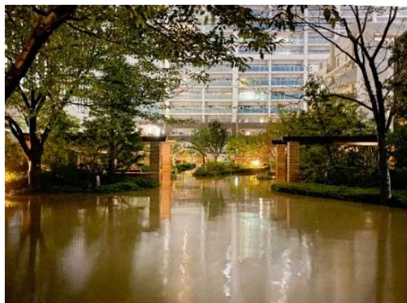
写真-14 B高層住宅 浸水時の建物周辺 出典：B高層住宅 報道用写真
