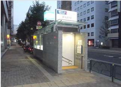
写真-34 建て替えた完全防水型出入口 出典：J 地下鉄施設 HP 風水害対策
