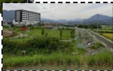
写真-7 平常時の二線提（肱側）
