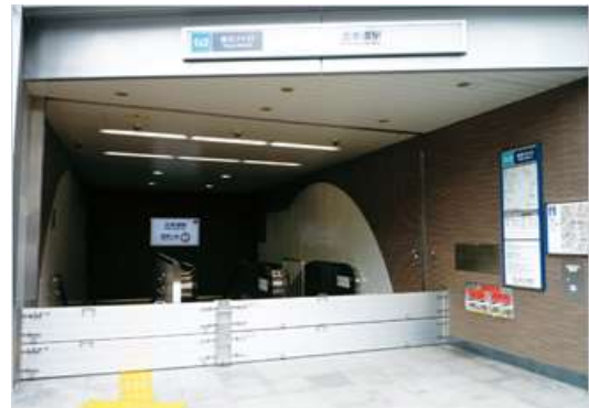
写真-35 駅出入口に設置した止水板 出典：J 地下鉄施設 HP 風水害対策
