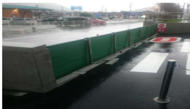
写真-18 C病院 防水堤
