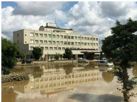
写真-20 E病院建物外観と浸水状況 出典：E病院HP
