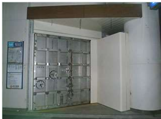
写真-36 既存構造を利用した完全防水型出入口 出典：J 地下鉄施設 HP 風水害対策
