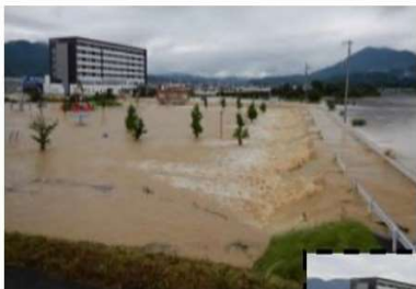
写真-6 二線提（肱川）からの越流 （愛媛県大洲市東大洲）
