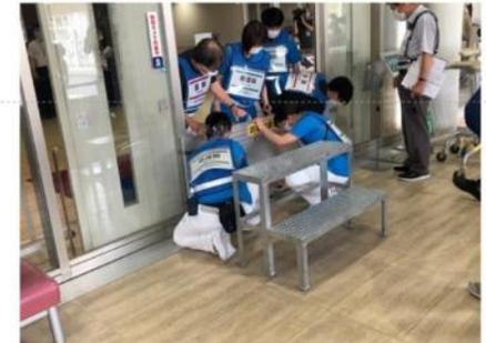
2022年5月6日に人吉医療センターで実施した水害タイムライン防災計画に基づく防災訓練の様子。浸水も防ぐ防水壁を設置している（写真：人吉医療センター、首都大学防災研究所、清水建設）
