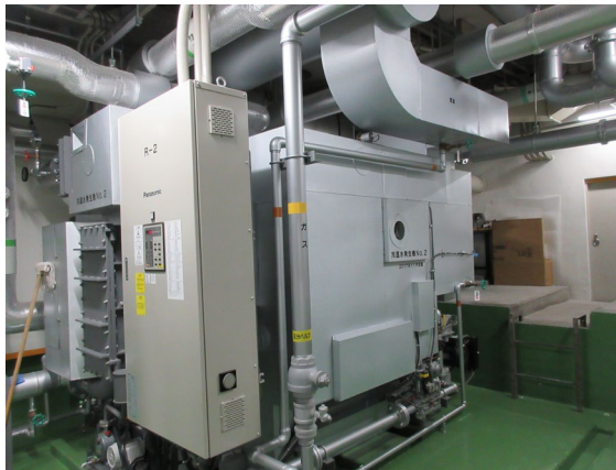
高効率冷温水機への更新
