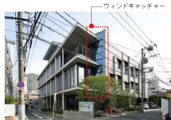
北西外観写真
