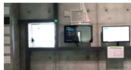
自然換気条件を表示するタブレット
