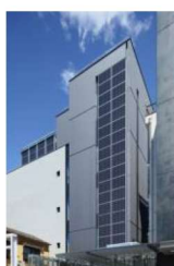
南側壁面設置のPV
