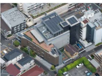
屋上設置のPV
