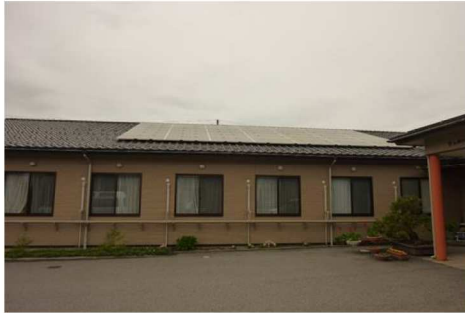
写真-4 太陽光発電設備設置状況
