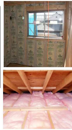
図-1 外壁・天井の断熱
